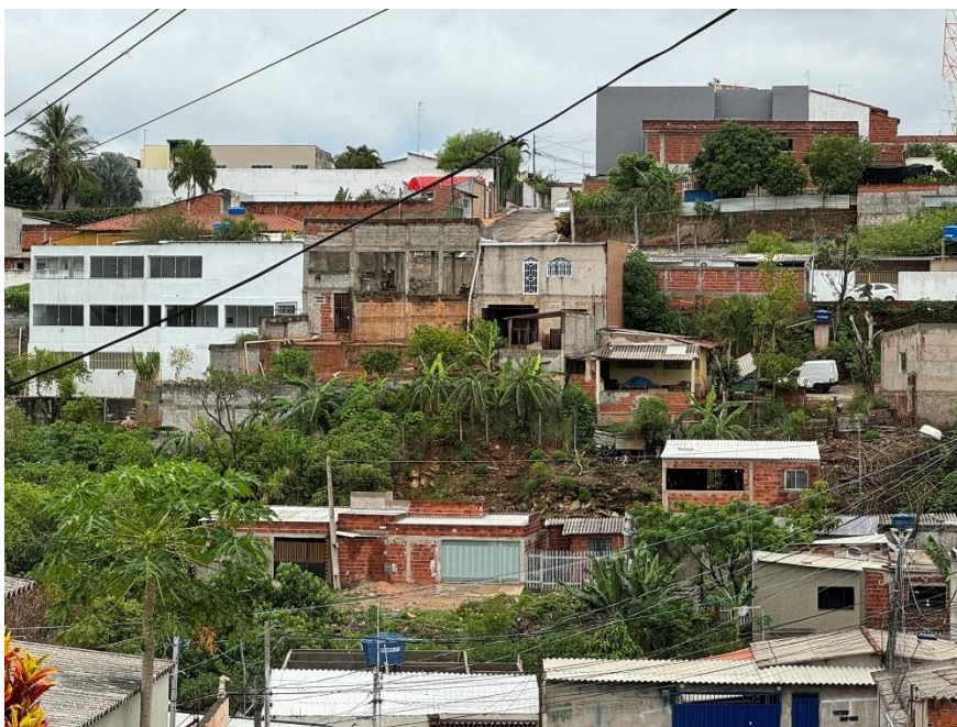
Figura 120 - Aspecto de vertente ocupada com risco de escorregamento de blocos e área de dispersão de queda.
