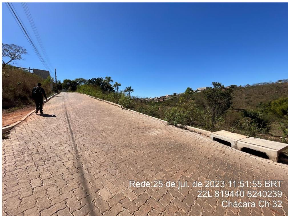
Figura 126. Trecho com boca de lobo e pavimentação com piso intertravado.
