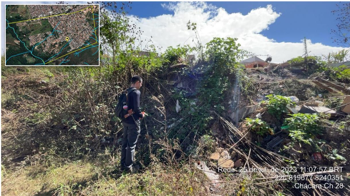
Figura 38. Aterramento de resíduos em área próxima ao canal de escoamento natural.
