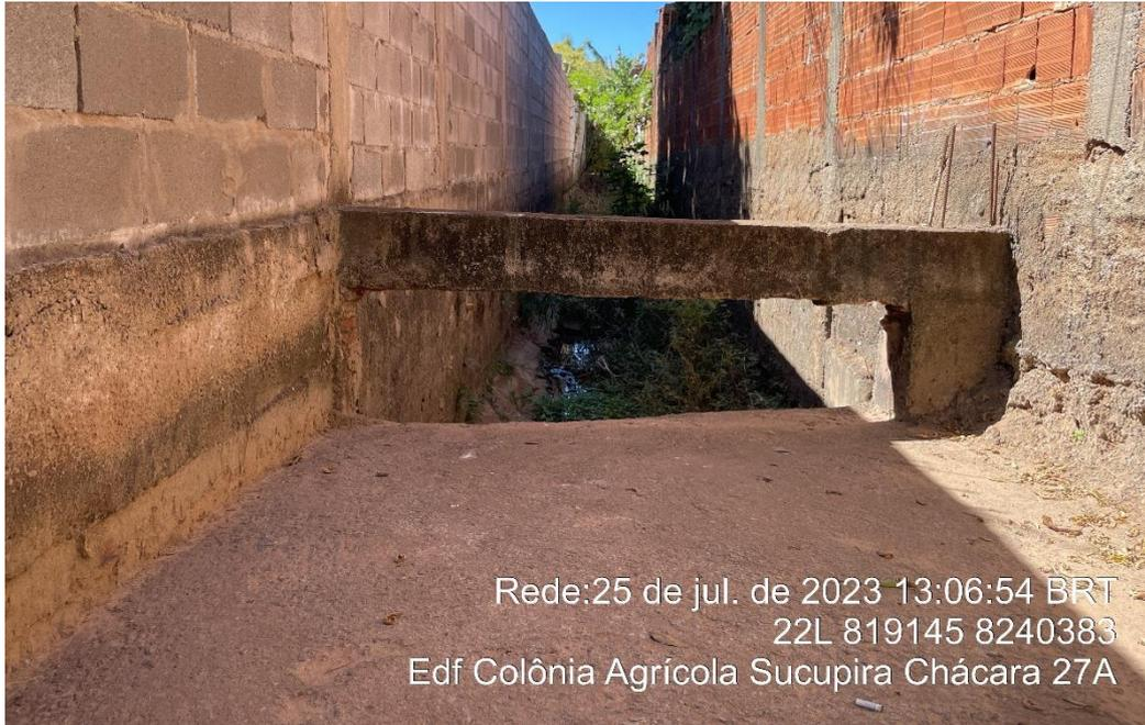
Figura 42. Passagem de águas pluviais, com a presença de efluentes residenciais.
