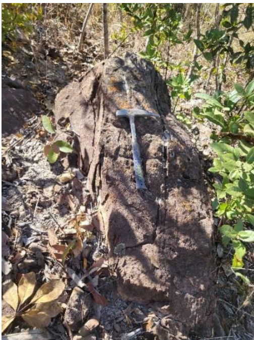
Figura 87 - Afloramento de quartzito maciço fraturado na área do Talude 03.
