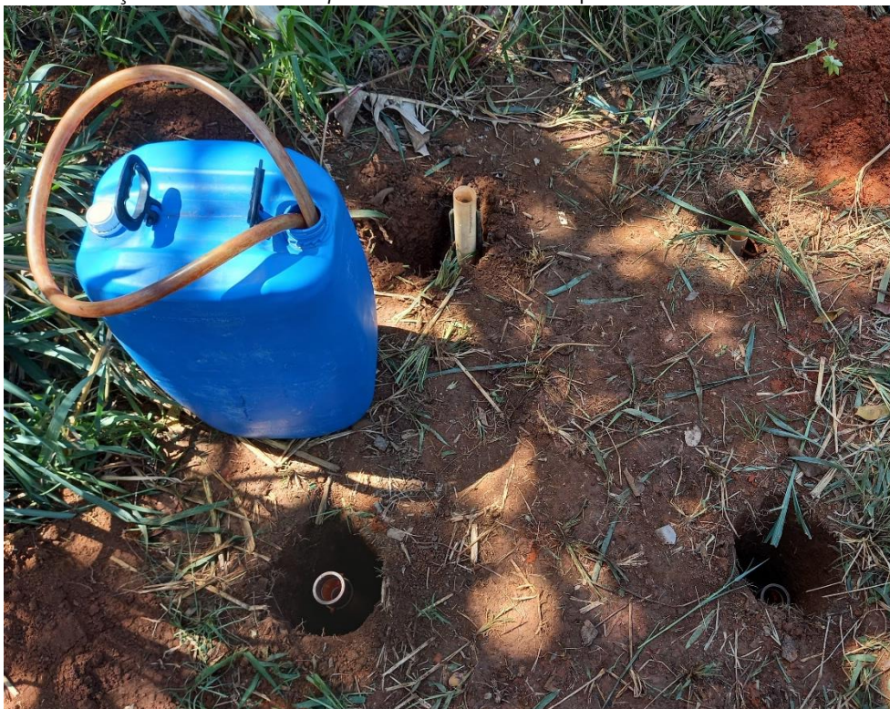
Figura 56 - Execução do método Open End Hole no empreendimento.
