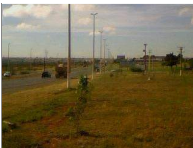
Foto 1 - Condição da área a ser implantada a drenagem junto a BR 070 (Extrema Construções LTDA)
