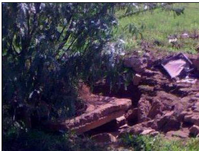
Foto 4 - Existência de Escoamento Lateral na Área de Contribuição - sem rede de drenagem (Extrema Construções LTDA)
