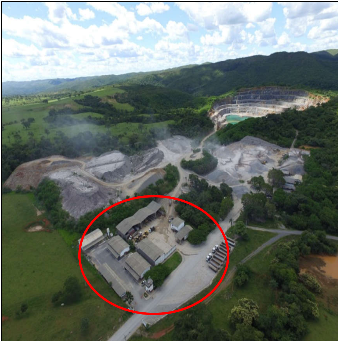
Figura 17: Área Administrativa da Planta de Beneficiamento da PEDREIRAS CONTAGENS. Foto aérea 2016.
