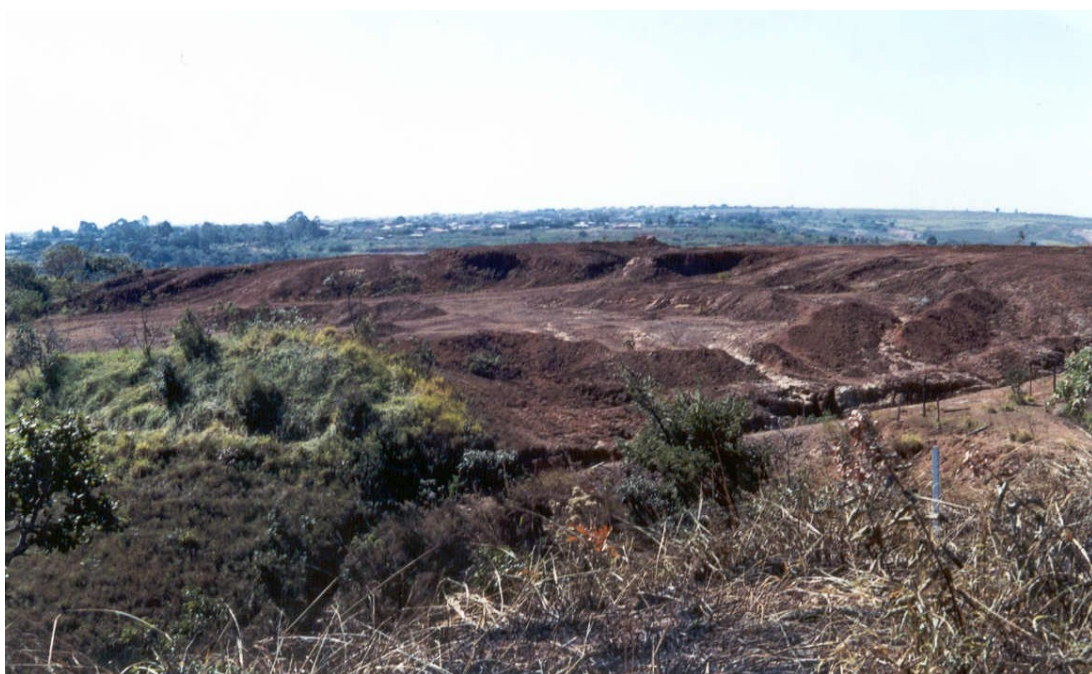
Foto 49 - Área perturbada nas proximidades do ribeirão Taguatinga (Ponto 24), presença de área de exploração de cascalho desativada, não recuperada.
