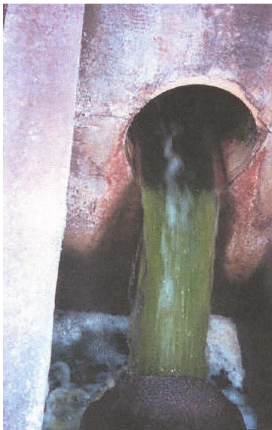
Foto 39 - Efluente do esgoto tratado da ETE Samambaia.
