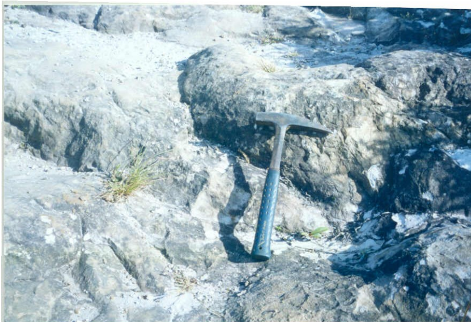
Foto 15- Quartzitos da unidade Q 3 situados na borda da Chapada. Notar o intenso fraturamento subvertical – Foto típica.
