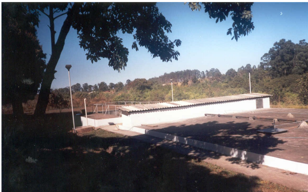
Foto 33 – Vista na direção NE-SW da ETE do Hospital Regional de Taguatinga.
