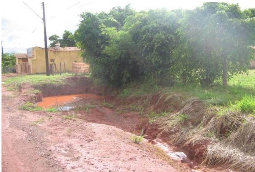
Figura 136–Bacias improvisadas em processo erosivo.
