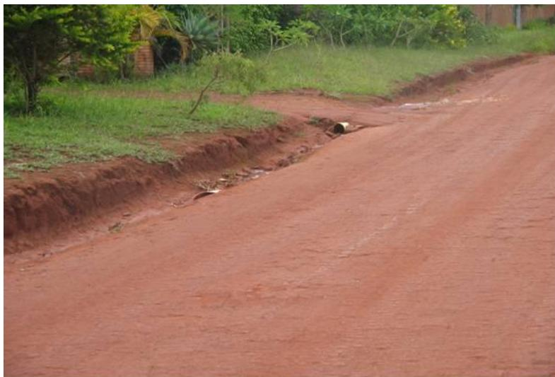
Figura 135—Canaletas improvisadas em processo erosivo.
