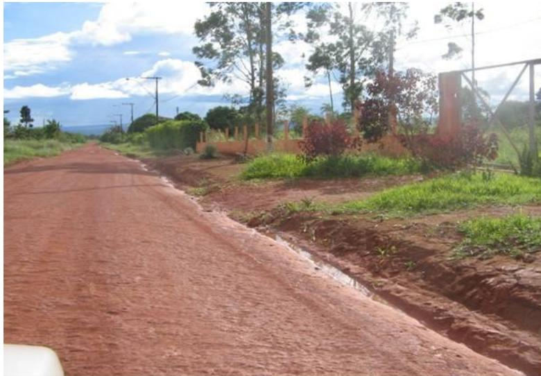
Figura 134—Canaletas improvisadas em processo erosivo.
