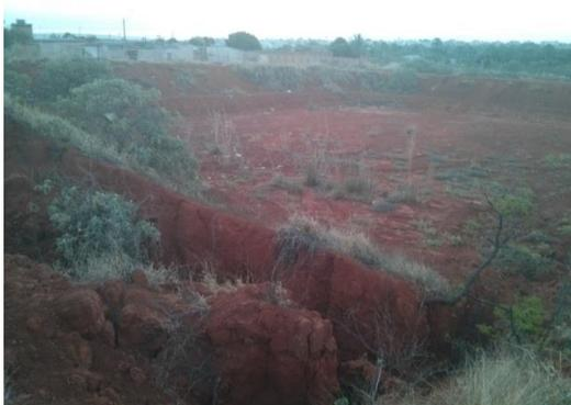
Fotografia 3: Erosão nos bordos do talude do Reservatório 03. E = 217373.1828 N = 8269870.7493
