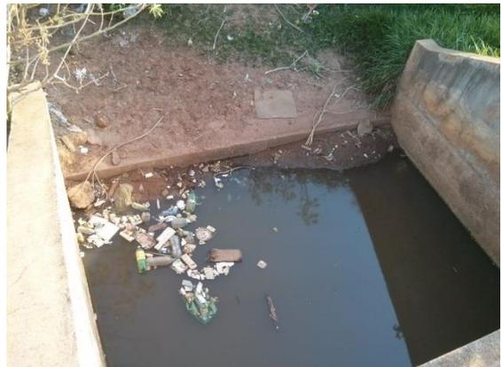
Fotografia 16: Acumulo de lixo carregado para o reservatório de detenção 04. E = 217926.5735 N = 8268055.5578
