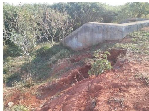
Fotografia 8: Chegada no reservatório 04 com talude em alto grau de processo erosivo. E = 217897.4465 N = 8268060.4057
