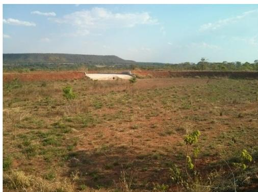
Fotografia 7: Visão geral do Reservatório 04 (qualidade), detalhe que não possui proteção vegetal nos taludes. E = 217821.9540 N = 8268004.8333
