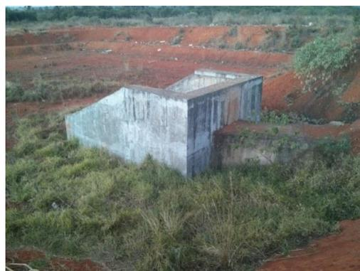
Fotografia 4: Detalhe da estrutura de chegada no reservatório 03 (dissipador de energia A4), e vegetação alta. E = 217560.4240 N = 8269917.6181
