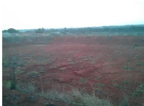
Fotografia 2: Visão geral do Reservatório 03 (qualidade), detalhe que não possui proteção vegetal nos taludes. E = 217404.9600 N = 8269885.8841
