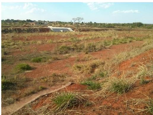
Fotografia 11: Reservatório 04 (quantidade) com vegetação alta, e lixo acumulado em alguns pontos.
