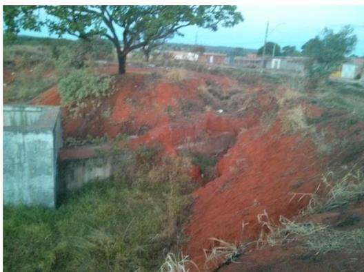
Fotografia 5: Chegada no reservatório 03 com talude em alto grau de processo erosivo. E = 217560.4240
