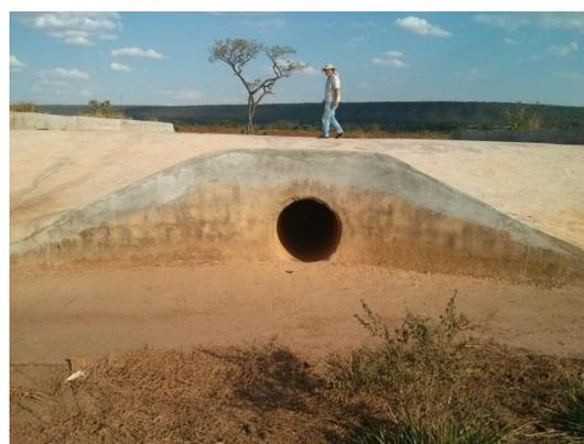
Fotografia 10: Descarga de fundo e vertedor de emergência do reservatório 04 (qualidade/quantidade), detalhes para ausência de grelha de proteção. E = 217793.2746 N = 8267938.4658
