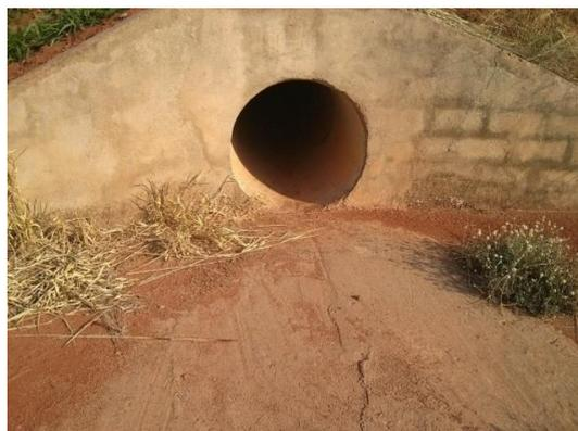
Fotografia 12: Descarga de fundo do reservatório 04 (quantidade) que direciona o fluxo para o lançamento 04.
