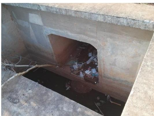
Fotografia 9: Presença de lixo na chegada do reservatório 04 (dissipador de energia A4). E = 217926.5735 N = 8268055.5578
