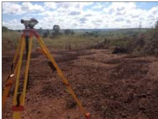
Figura 1. Medidas de conservação do solo, com Terraceamento na Cascalheira Rajadinha.
