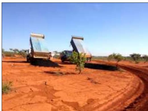
Figura 3. Descarregamento de lodo na área do projeto RFFSA.
