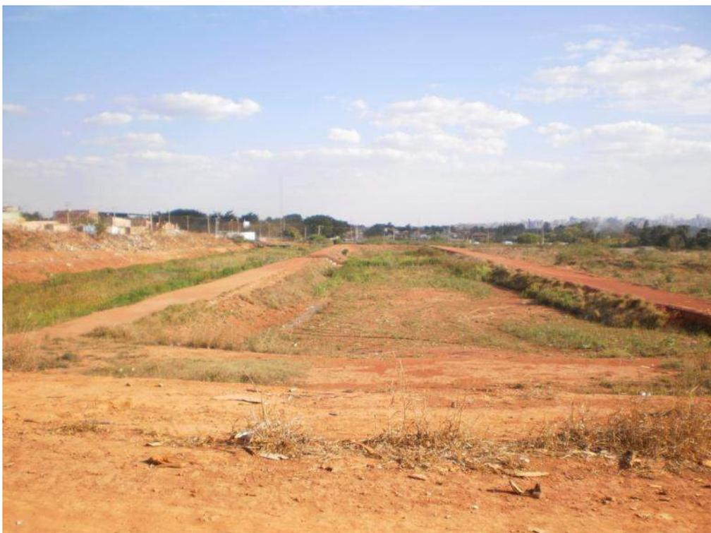
Figura 27 – Bacias de contenção de drenagem pluvial.
