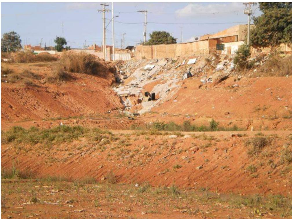
Figura 30 – Ponto de descida do escoamento superficial, com restos de cimento e entulho depositados pela população para contenção dos processos erosivos.
