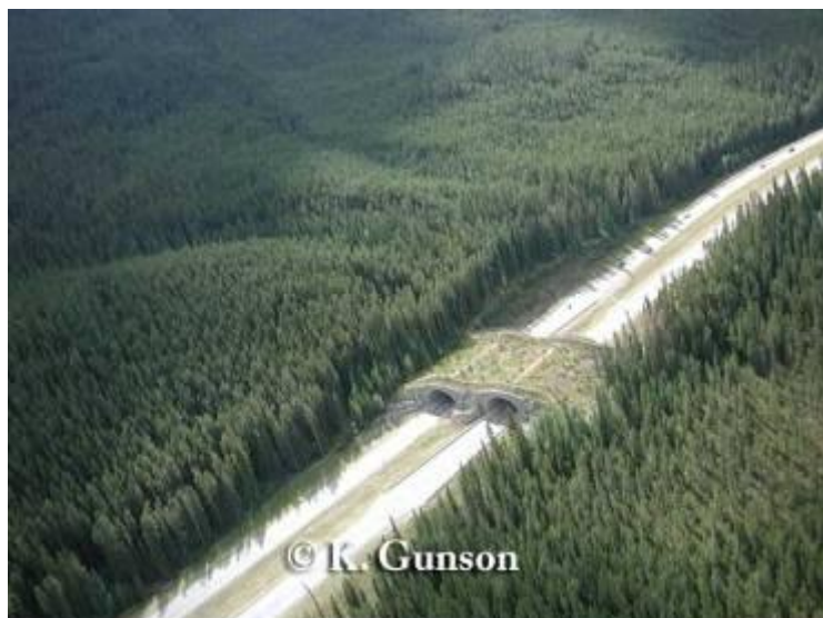
Figura 3. Overpass sobre a rodovia Trans-Canada, no Banff National Park, Alberta, Canadá.
