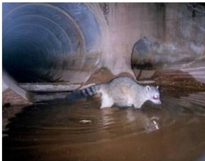
Figura 1. Passagem de Fauna sob a Rodovia do Sol ES-060 no Espírito Santo.
