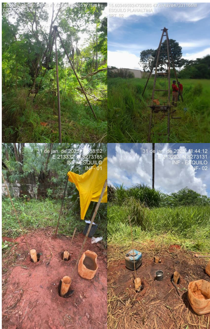
Figura 3: Fotos da execução de algumas das sondagens.
