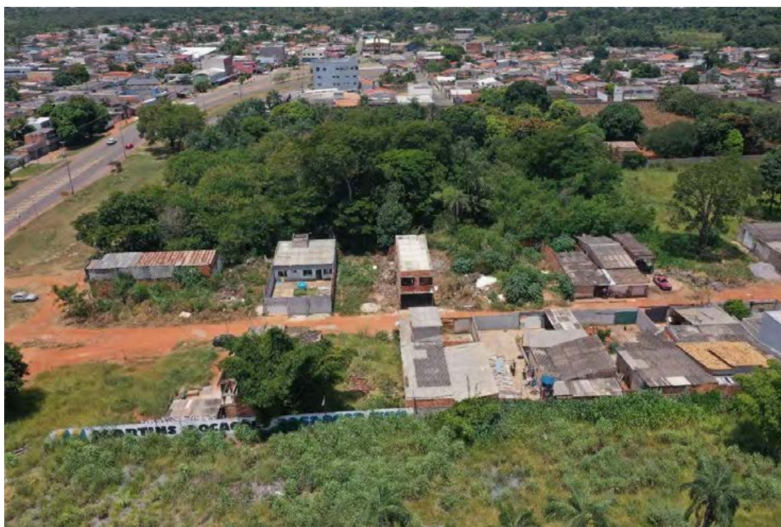
Foto 16: Área de estudo, com foco na área não construída, sentido sudeste.
