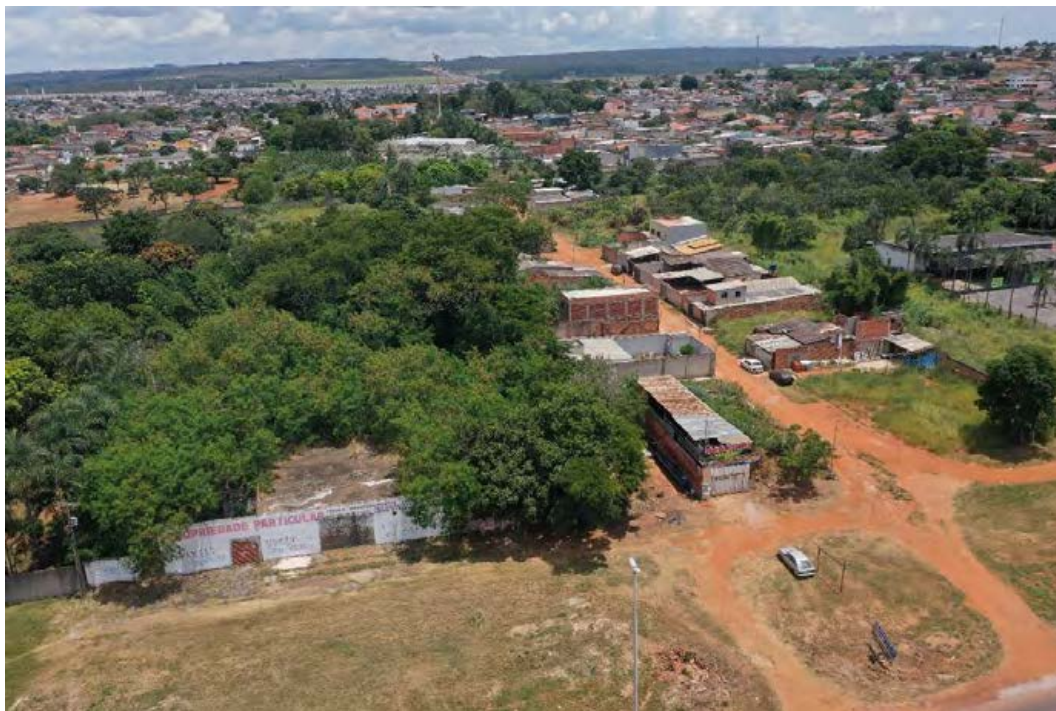
Foto 12: Imagem aérea que evidencia o elevado grau de descaracterização fitofisionômica da Área Diretamente Afetada (ADA) e da Área de Influência Direta (AID), com predominância de cobertura vegetal alterada e ausência dos padrões característicos do Cerrado nativo.
