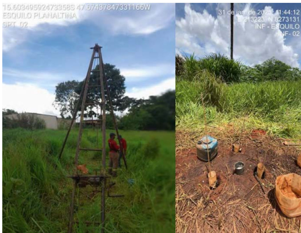
Foto 6: Sondagem SPT e Ensaio de Infiltração realizados na ADA.
