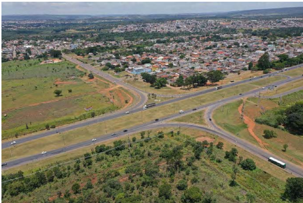
Foto 26: Entroncamento entre as rodovias BR-020 e DF-128.
