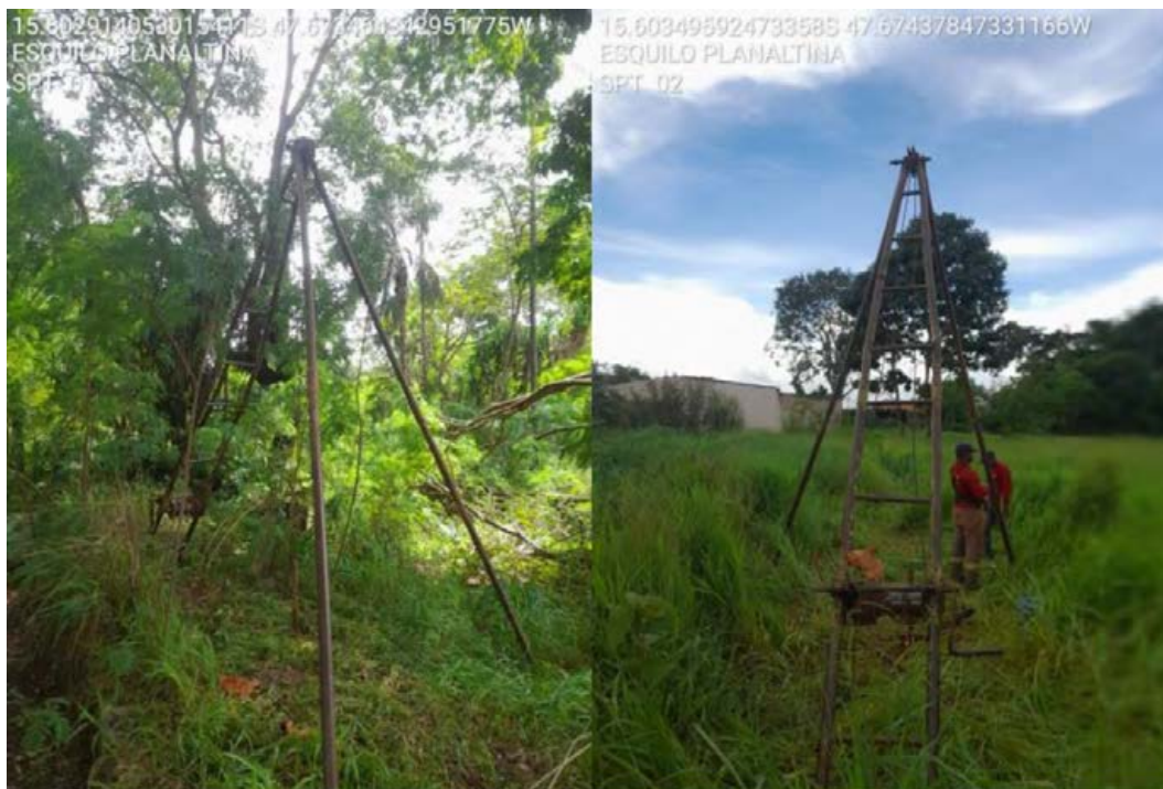
Foto 3: Execução dos ensaios SPT na Área Diretamente Afetada (ADA).
