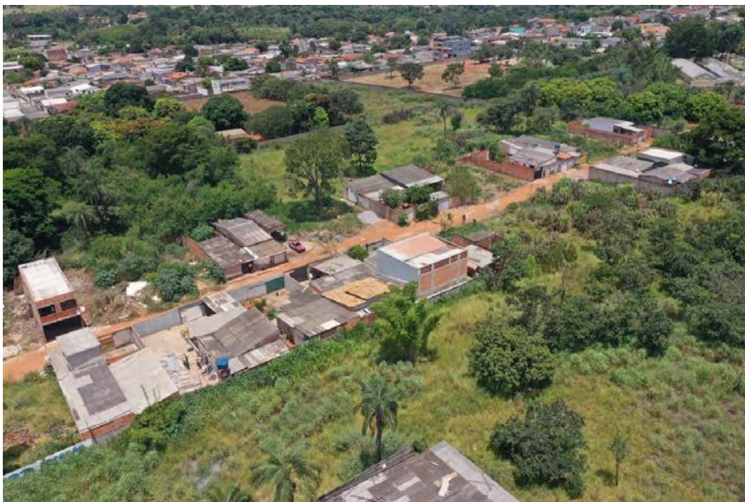
Foto 31: Área ocupada com edificações na ADA.
