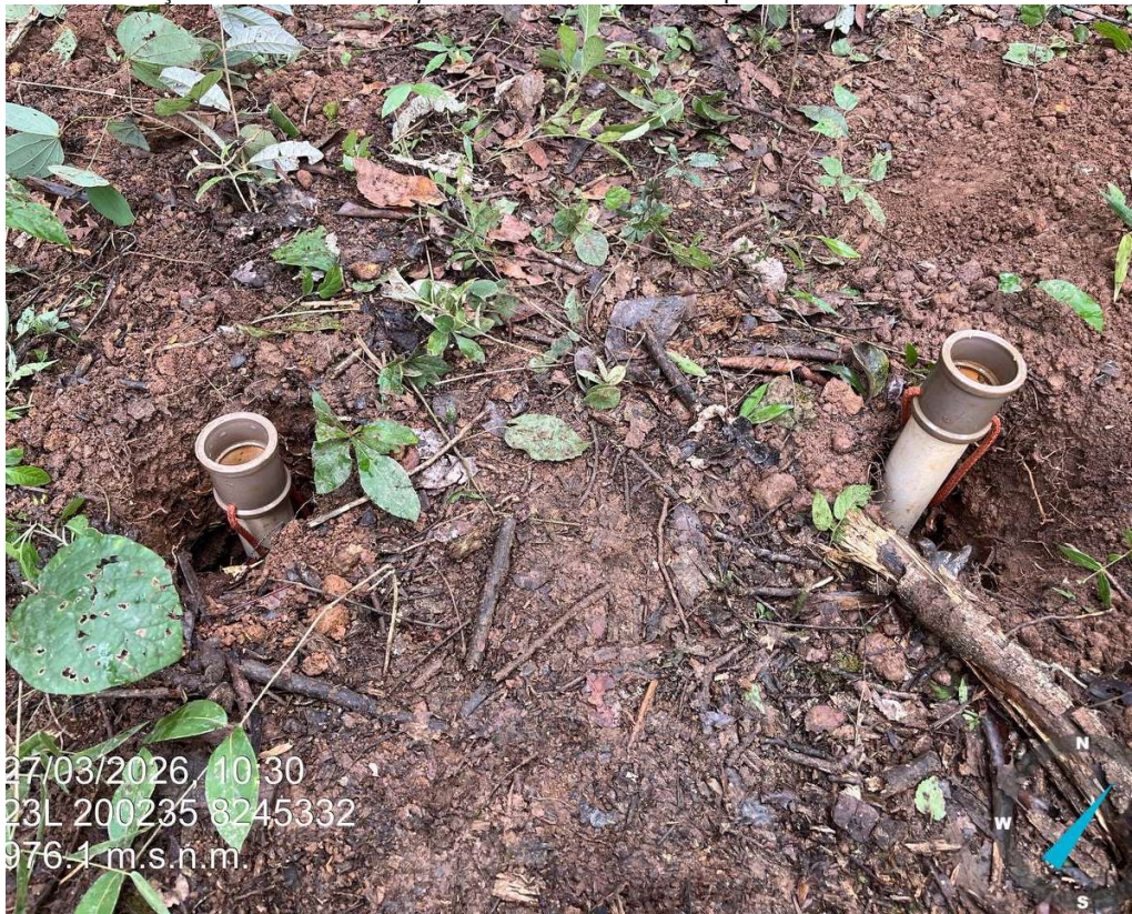
Figura 65 - Execução do método Open End Hole no empreendimento.
