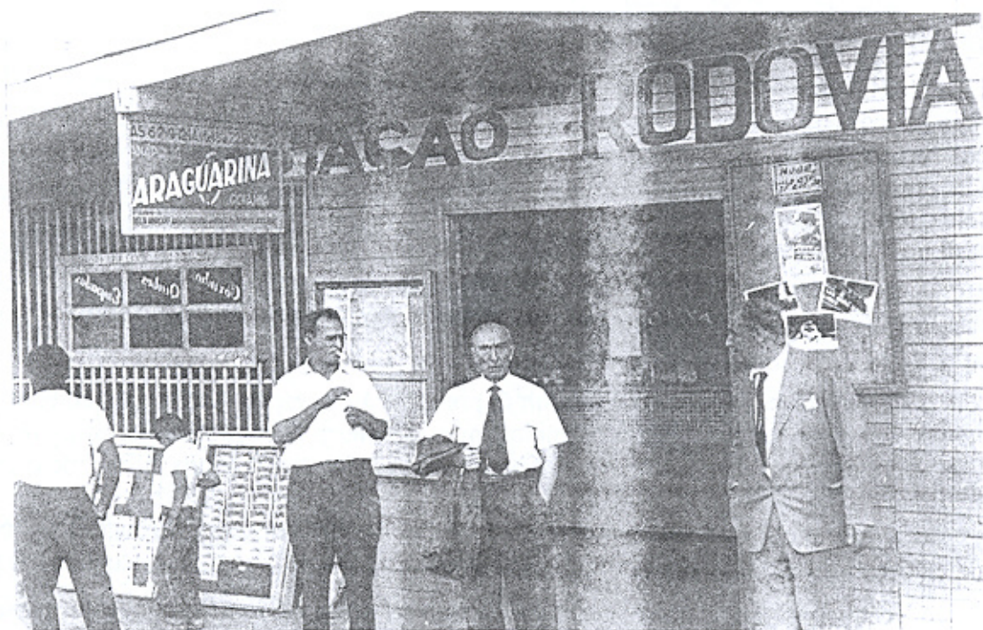
Figura 14. Estação Rodoviária do Núcleo Bandeirante. Fotografia de 30.09.58.
