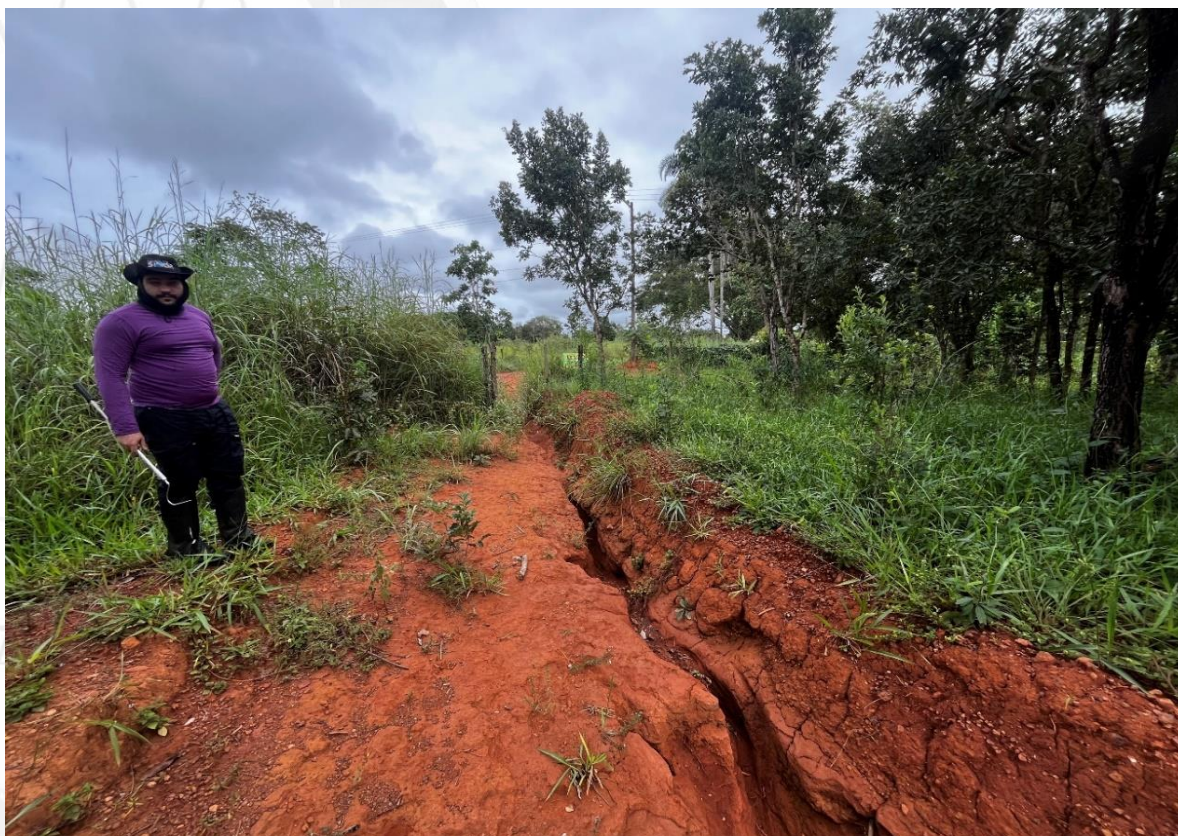
Foto 25: Feição erosiva identificada na AID, com aprofundamento do solo e indícios de erosão linear ativa.
