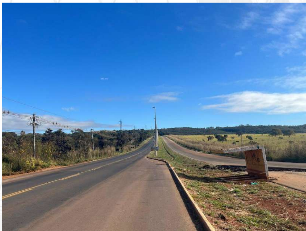
Foto 21: Trecho concluído da duplicação da DF-140.
