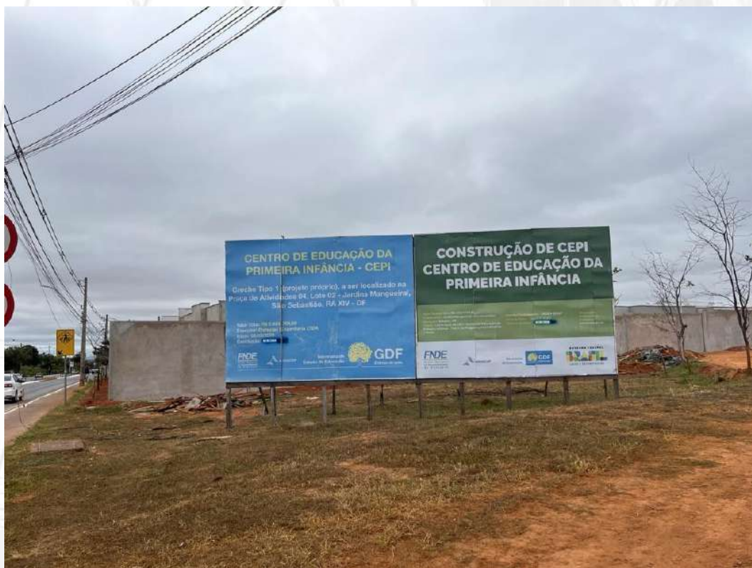
Foto 7: Centro de Educação da Primeira Infância – CEPI (em construção).
