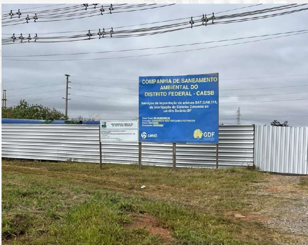
Foto 16: Obra de implantação de adutora de interligação.
