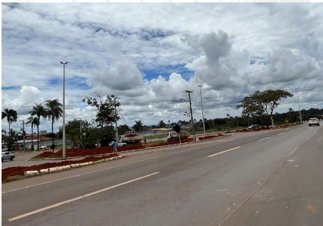
Foto 20: Trecho concluído da duplicação da DF-140.
