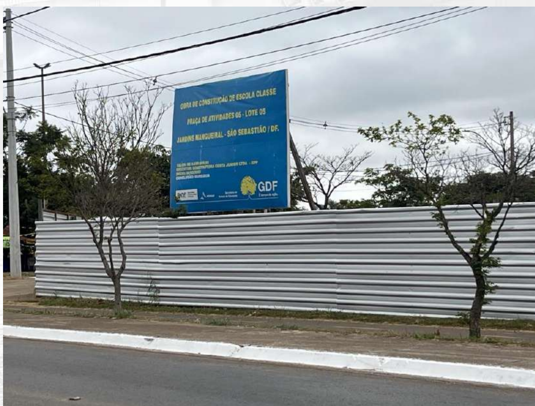
Foto 8: Escola Classe (em construção).
