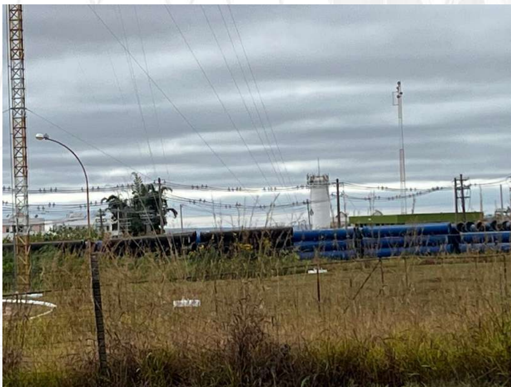
Foto 17: Obra de implantação de adutora de interligação.
