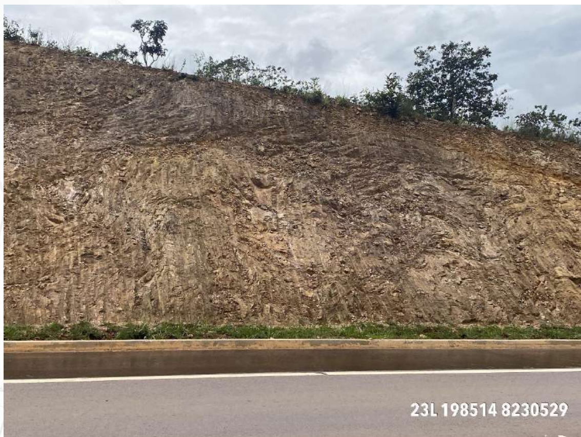
Foto 1: Perfil, em corte de estrada, de metarritmito argiloso da Formação Córrego do Sansão.
