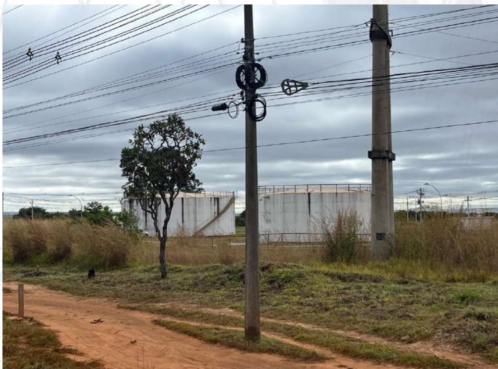
Foto 15: Reservatório de água – CAESB.
