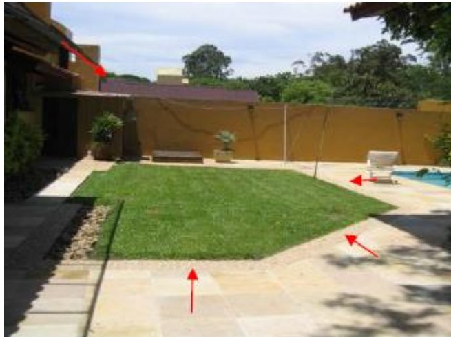
Figura 13 – Escoamento direcionado para área gramada.
