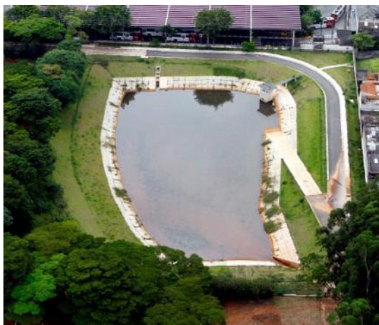
Figura 9 – Reservatório de detenção, em São Paulo-SP.
