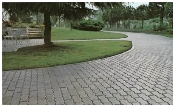
Figura 16: Via local utilizando pavimento permeável.
