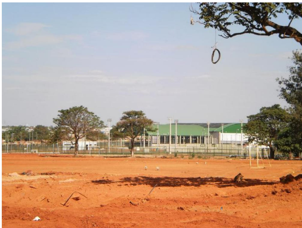
Figura 23 – Vila Olímpica em destaque. Notar terraplenagem realizado para construção de campo de futebol de terra no primeiro plano da foto.
