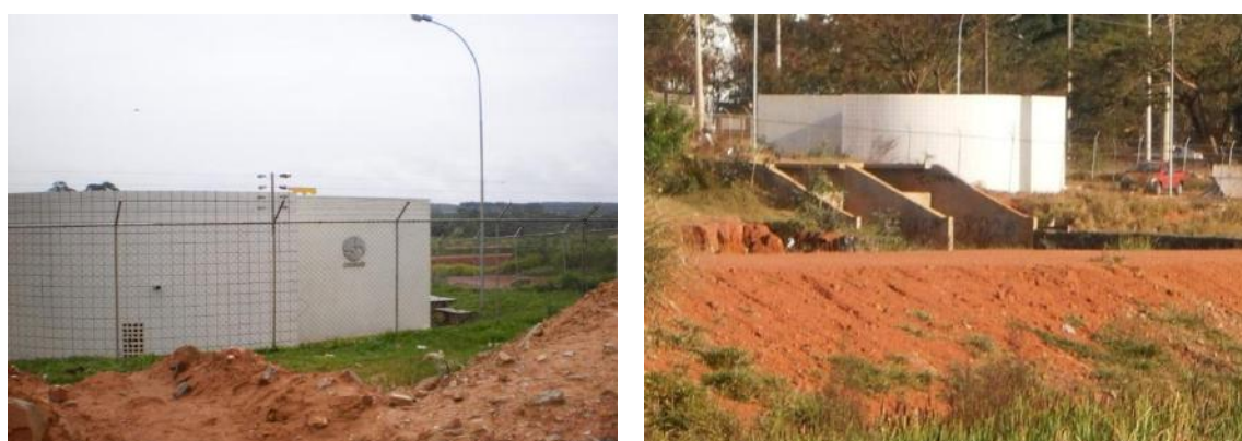
Figura 131 – Estação elevatória da Caesb.
