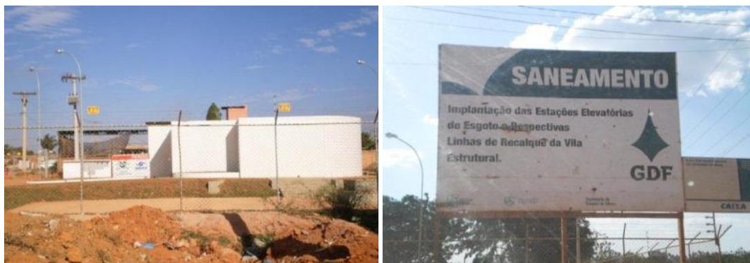
Figura 130 – Implantação do sistema de esgotamento sanitário na Vila Estrutural – Linhas de recalque.
