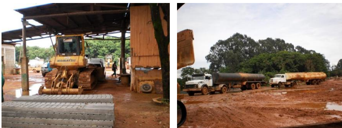
Figura 141 – Maquinários utilizados no aterro.
