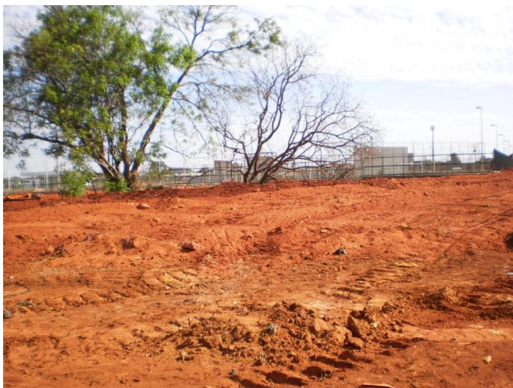
Figura 24 – Aterro realizado no Parque Urbano da Vila Estrutural. Notar Vila Olímpica ao fundo.
