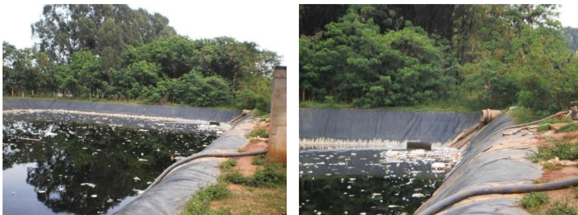
Figura 143 – Lagoa de chorume. Destaque para o duto de chorume.
