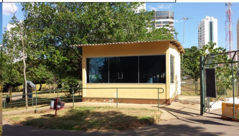
18- GUARITA NA ENTRADA PRINCIPAL DO PARQUE
