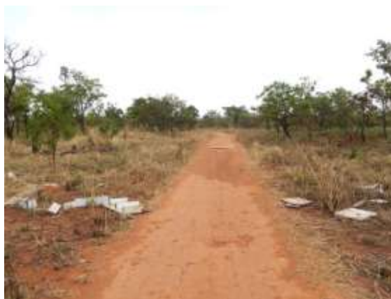
Pista irregular no interior do Parque favorecendo a degradação.
