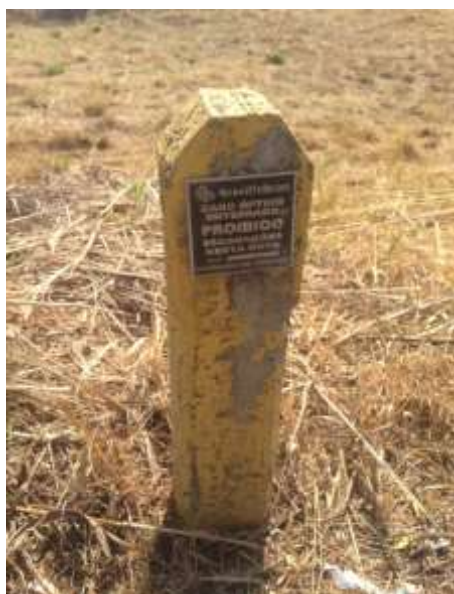
Cabo óptico enterrado ao longo da via
