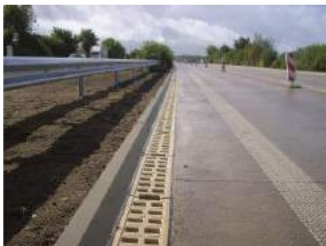
Fotografia 1: Detalhe de aplicação de canal monobloco de concreto polímero em rodovias.
