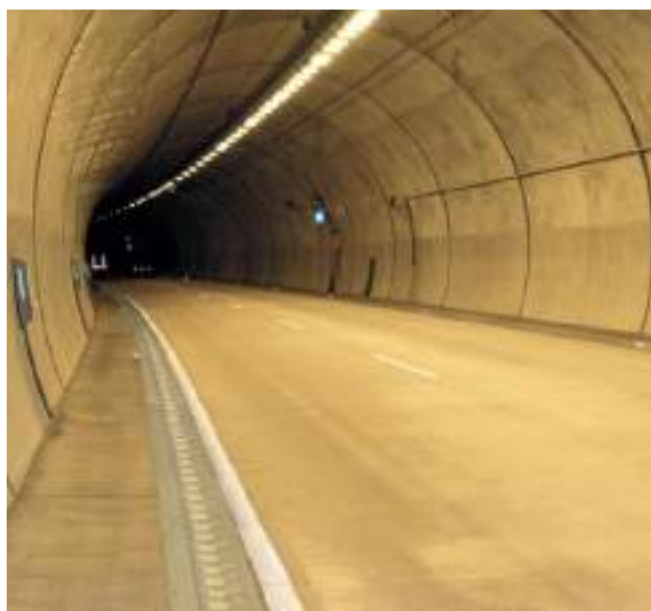
Fotografia 3: Detalhe de aplicação de canal monobloco de concreto polímero em túnel.
