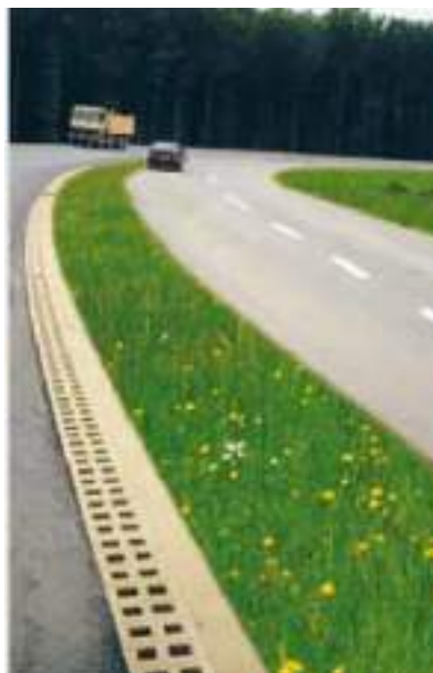
Fotografia 2: Detalhe de aplicação de canal monobloco de concreto polímero em rodovias.
