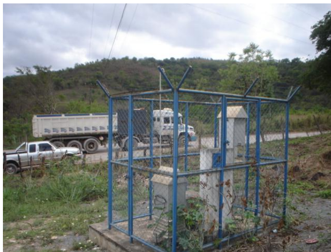
Figura 8- Estação da Fercal II
