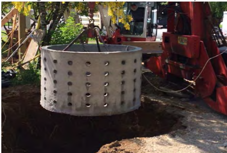
Figura 10 - Tubos perfurados (Foto meramente ilustrativa).
