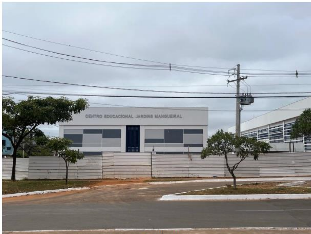
Foto 5 – Centro Educacional Jardins Mangueiral (em construção).
