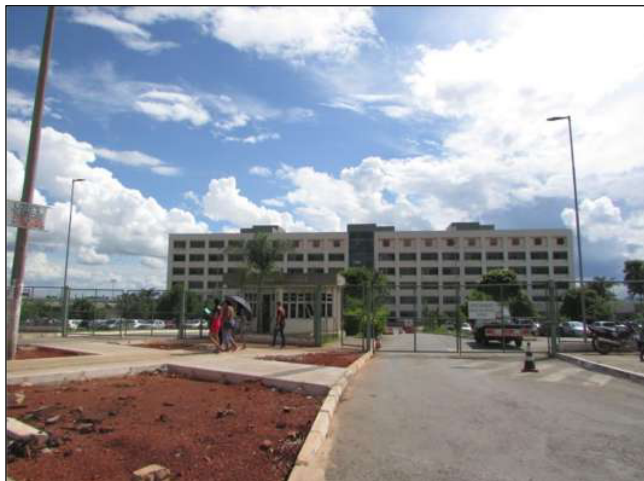
Foto 53: Hospital Regional da Santa Maria.
