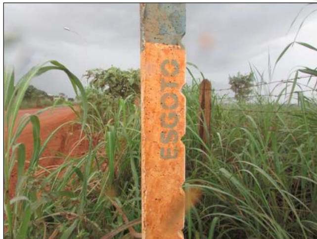
Foto 72: Marco em área próxima ao empreendimento indicando rede de esgoto.
