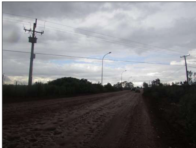
Foto 74: Rede Elétrica em área próxima a ADA.
