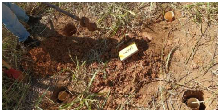
Foto 13: Preparo da tubulação para o ensaio pelo método open end hole .
