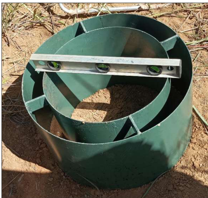
Foto 12: Nivelamento do anel externo para garantir a infiltração vertical da água. Localização: 820.254 E / 8.223.510 S, 22 L.
