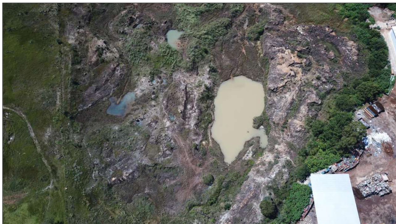
Foto 25: Detalhe da água acumulada na área degradada pela mineração, onde se percebe que há ravinas à montante da maior lagoa escoando água para as cavas formadas pela desconformidade topográfica da lavra mineral a céu aberto.
