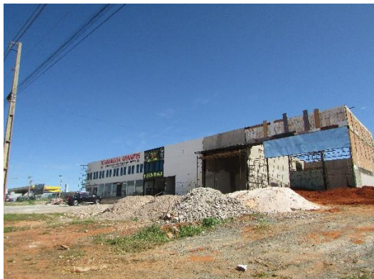
Foto 31 - Distribuidora de Granitos e Mármore. UTM: 180144/8223367.
