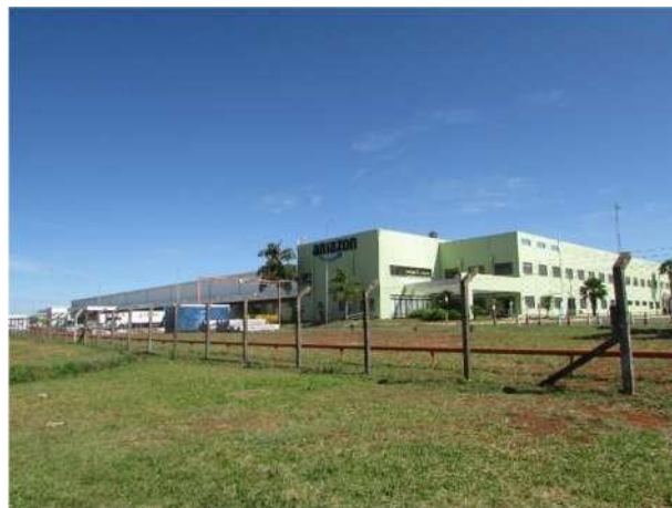
Foto 96 - Edificações na área adjacente à rodovia DF-290, sentido oeste da gleba.
