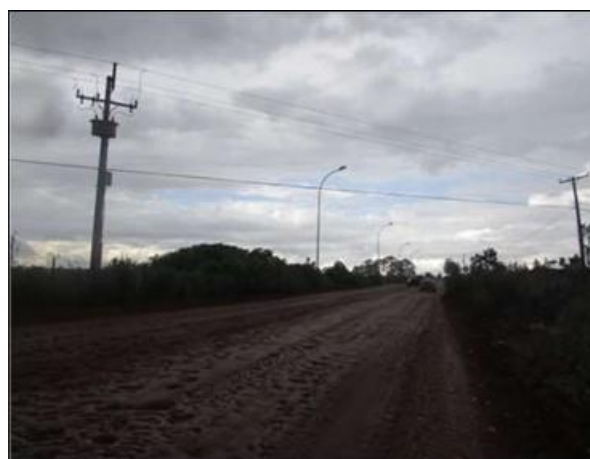
Foto 171 - Rede Elétrica em área limítrofe a ADA.
