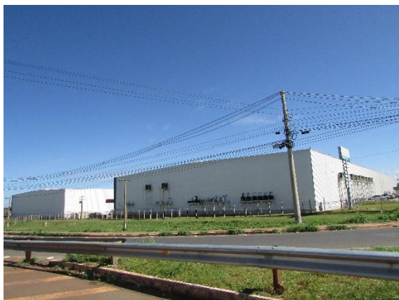
Foto 37 - Galpão Logístico. UTM: 820487/8223335.
