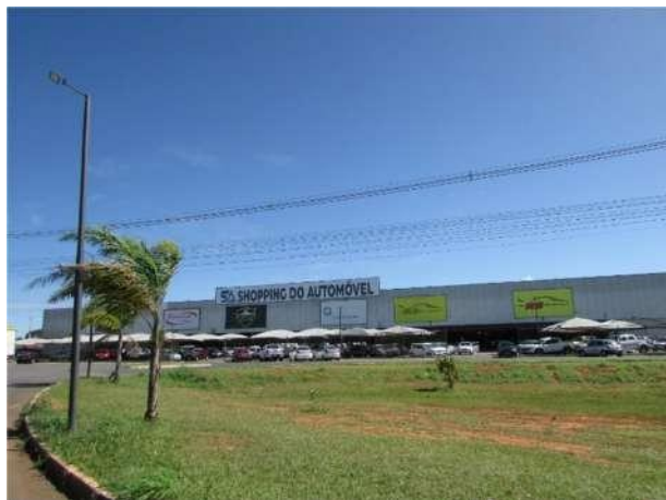
Foto 95 - Edificações na área adjacente à rodovia DF-290, sentido oeste da gleba.
