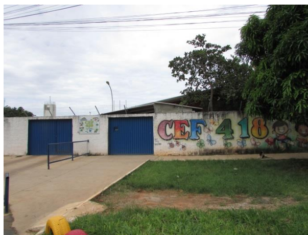
Foto 52 - Centro de Ensino Fundamental 418. UTM: 180424/8227219
