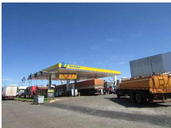
Foto 35 - Posto de Gasolina. UTM: 179789/8223387.
