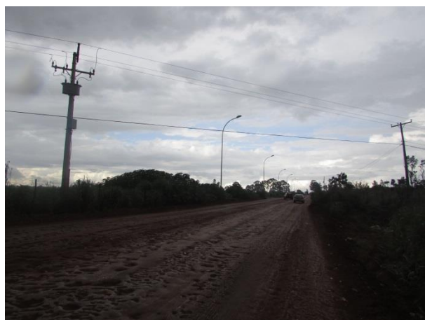
Foto 90 - Rede Elétrica em área limítrofe ao empreendimento. UTM: 179989/8226041
