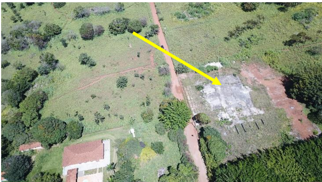
Figura 11 - Ruínas de edificações demolidas.
