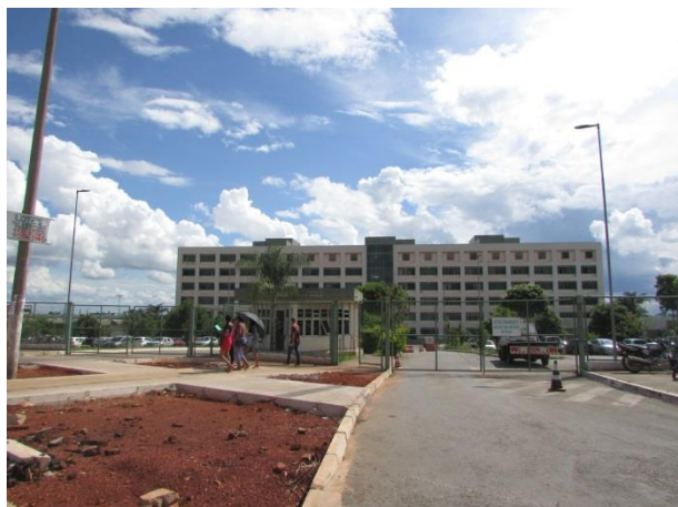
Foto 65 - Hospital Regional da Santa Maria.
