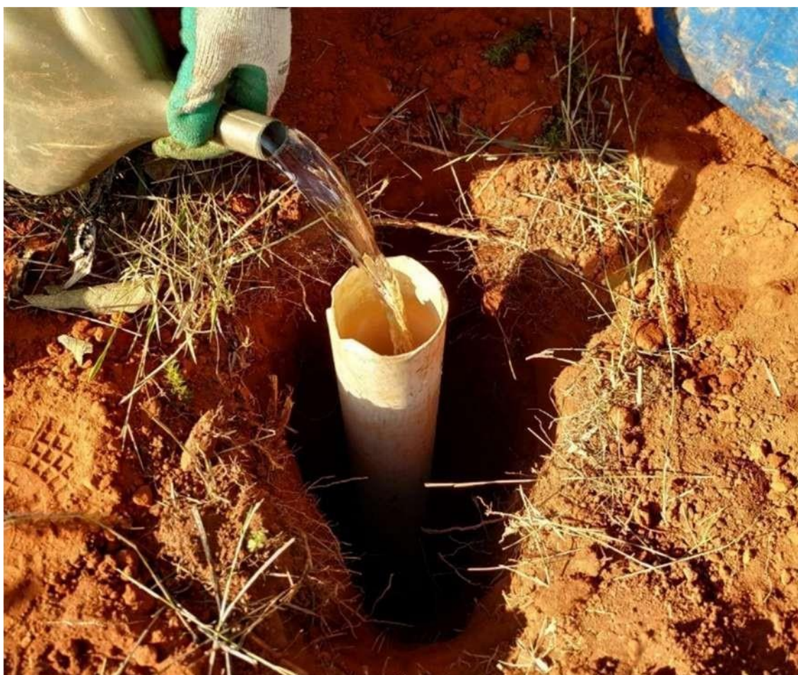
Figura 8 - Preenchimento do cano PVC com água para posterior medição da altura do nível d'água.
