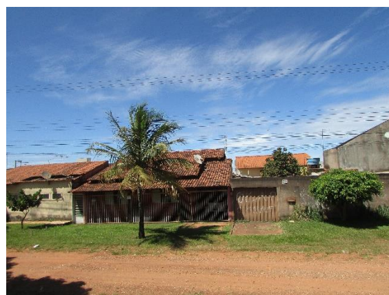
Foto 44 - Residências às margens da rodovia DF-290.
