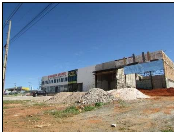
Foto 94 - Edificações na área adjacente a rodovia DF-290, sentido oeste da gleba.
