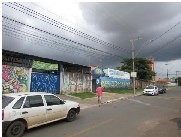
Foto 60 -Centro de Ensino Fundamental 213. UTM: 178559/8227785
