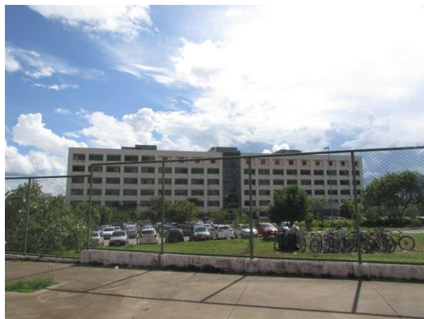
Foto 66 - Hospital Regional da Santa Maria.
