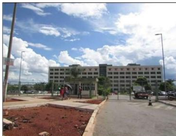
Foto 149 - Hospital Regional da Santa Maria.
