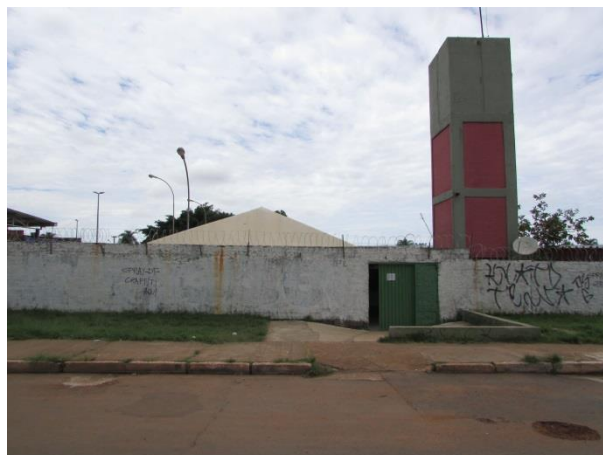
Foto 54 - Centro de Ensino Fundamental 316. UTM: 179478/8227530
