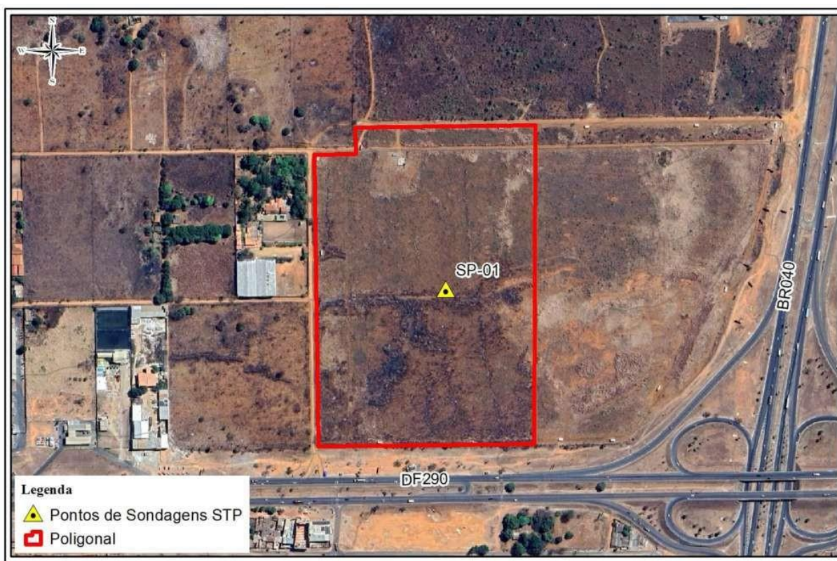
Figura 4 - Poligonal onde foi realizado o ensaio e localização central do ponto de ensaio de sondagem SPT em área na ADA.
