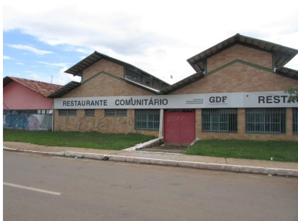
Foto 83 - Restaurante Comunitário. UTM: 177177/8226838
