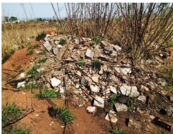
Foto 25 - Descarte entulho e exposição de solo na porção sudeste da área. Localização: 180.633 E / 8.223.627 N, 23 L
