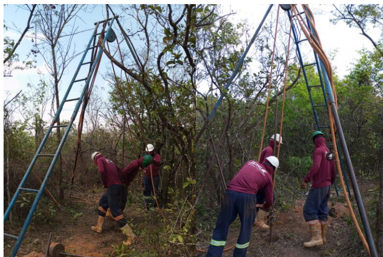
Figura 3: Fotos da execução da sondagem.
