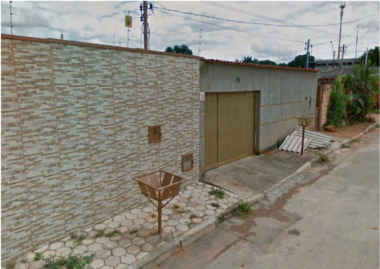
Figura 64. Resíduos sólidos dispostos para coleta e caixas de medição de energia.
