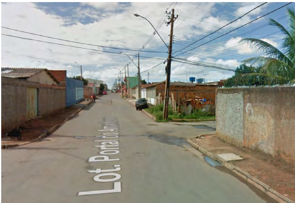
Figura 63 – Rede de energia e telefonia e boca de lobo de drenagem em rua adjacente ao parcelamento, na ocupação conhecida como portal do amanhecer. Fonte: Google street view
