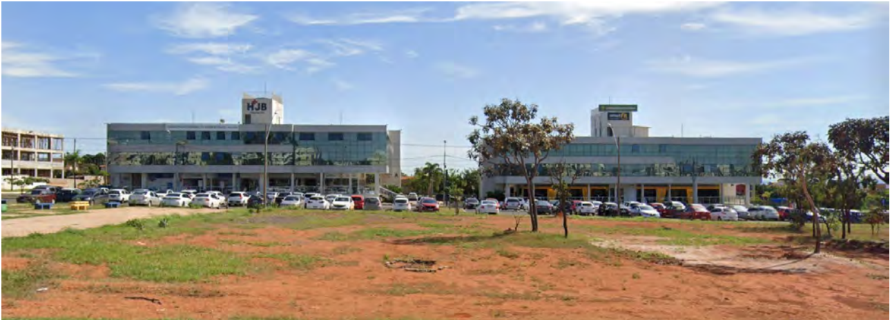
Figura 80 : Visão da Administração Regional do Jardim Botânico, localizada próximo a DF-463
