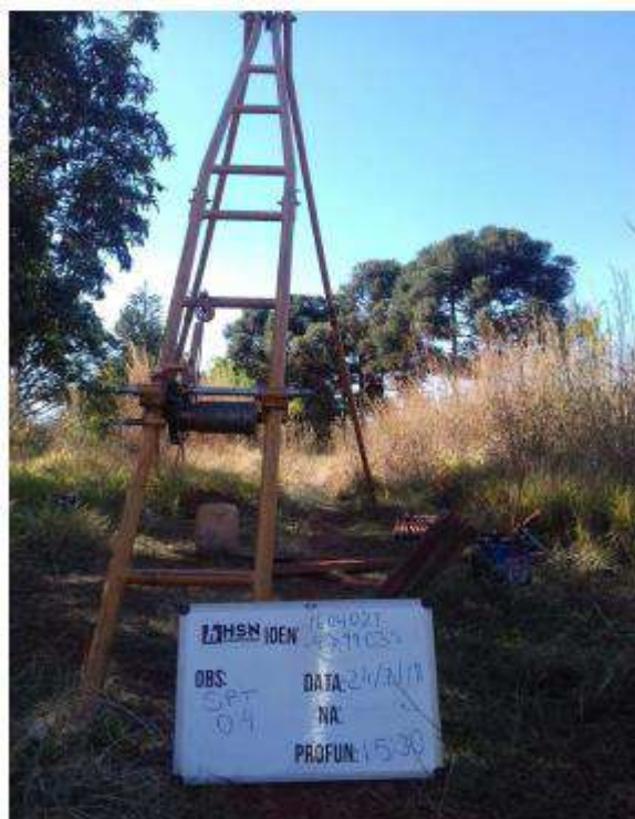
Figura 7.11. Estrutura para realização do ensaio de SPT no Ponto 04.
