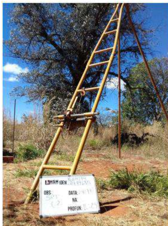
Figura 7.12. Estrutura para realização do ensaio de SPT no Ponto 02.
