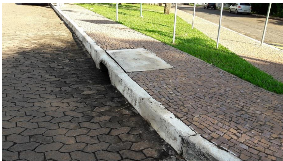
Figura 8. Meio-fio instalado no Condomínio.
