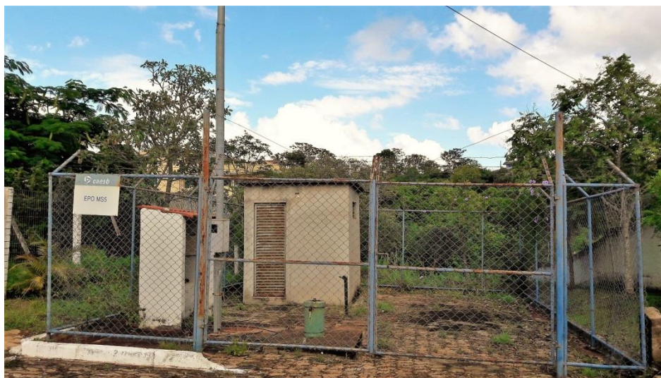
Figura 21. Poço tubular profundo desativado, mas devidamente cercado.
