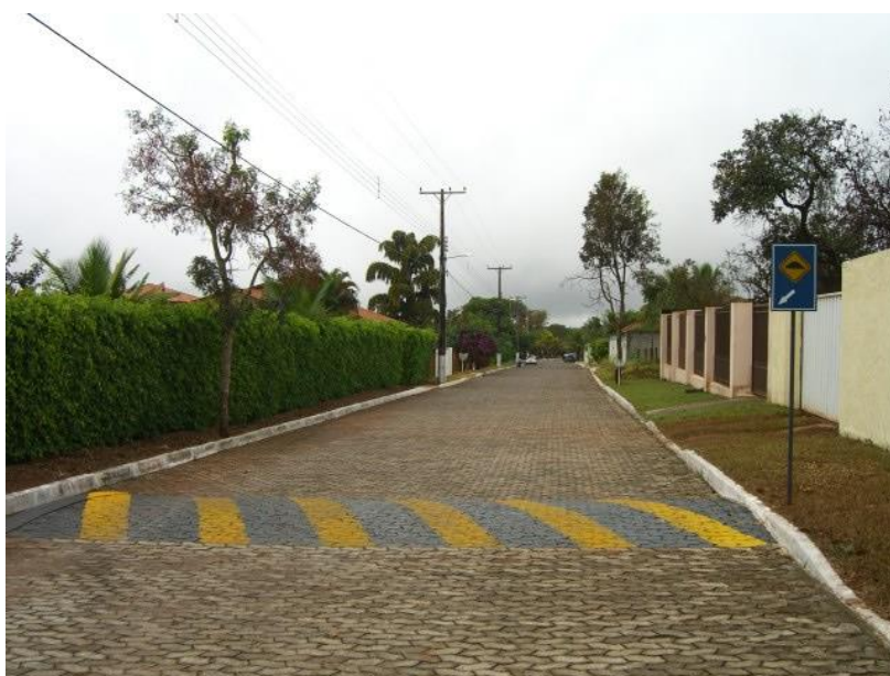
Figura 6. Redutor de velocidade devidamente sinalizado implantado no Condomínio.
