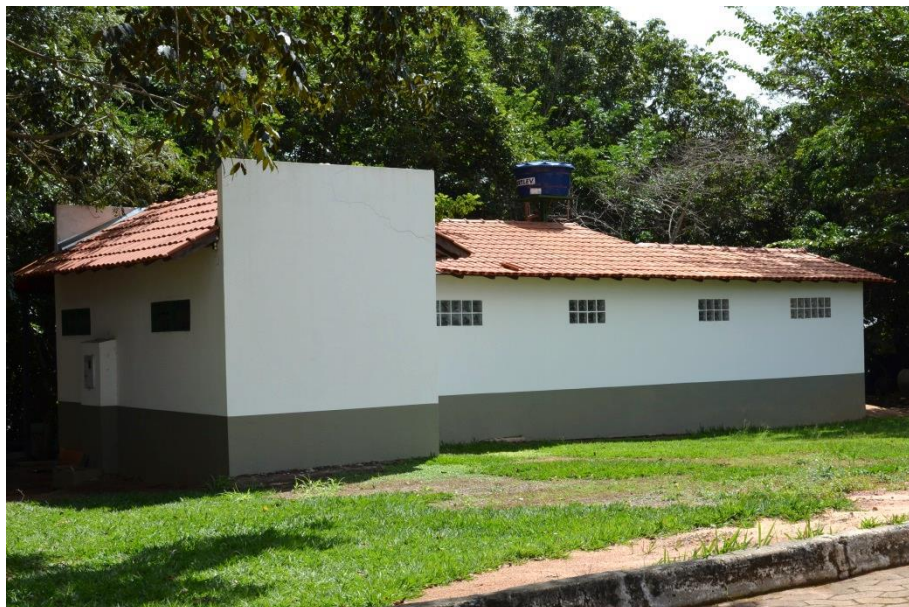
Figura 16. Ponto de apoio aos funcionários do Condomínio, onde houve a instalação da Ecofossa.
