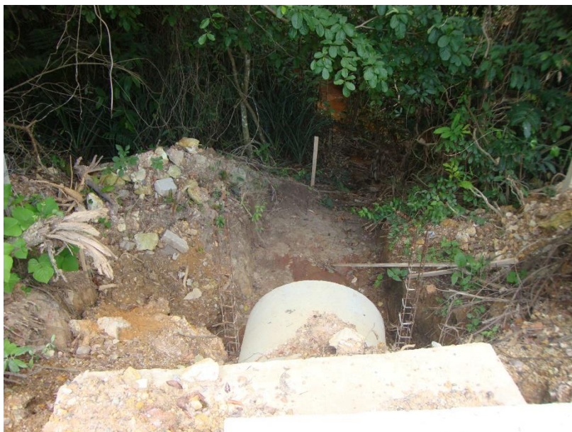
Figura 15. Local em preparação para a construção do dissipador de energia.
