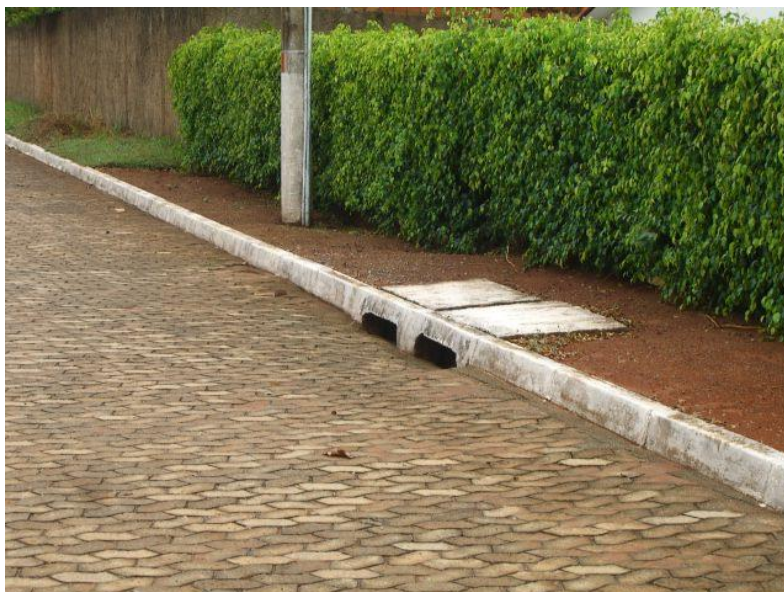
Figura 12. Ponto de captação de águas pluviais.
