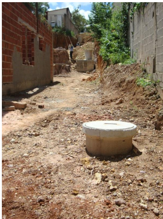
Figura 13. Implantação do sistema de drenagem das águas pluviais provenientes dos Conjuntos 16 e 17.
