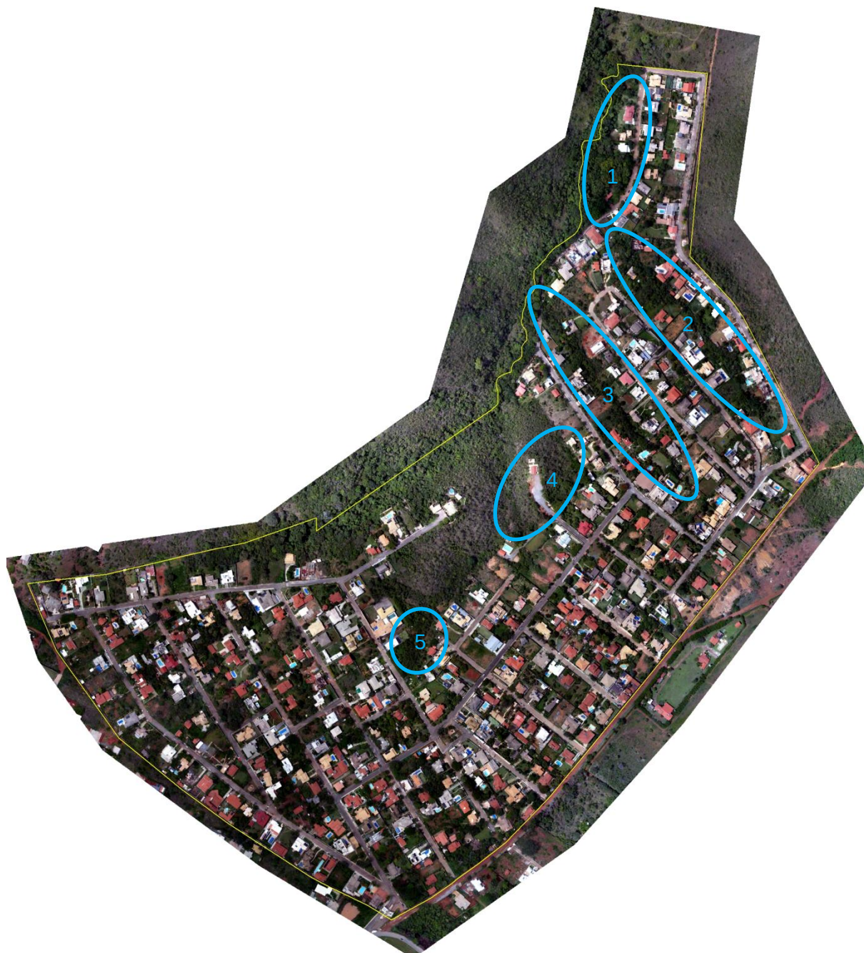
Figura 56. Aerolevantamento realizado em 2017, indicando as áreas em discussão (Fonte: contratado pelo Condomínio).
