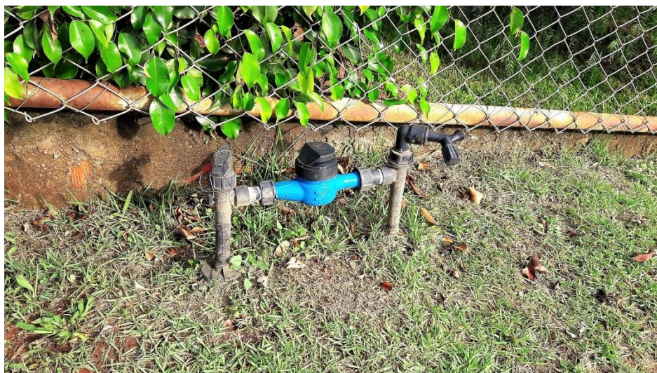
Figura 22. Exemplo de hidrômetro instalado no Condomínio.
