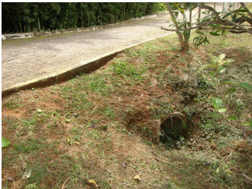
Figura 45. Passagem de água construída sob a via de acesso a Piscina.
