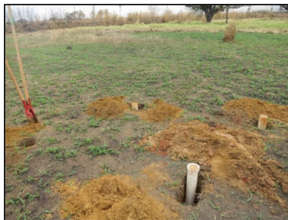
Foto 8: Tubos de PVC cravados no solo. Localização: 803.271 E / 8.250.645 N, Zona 22L.
