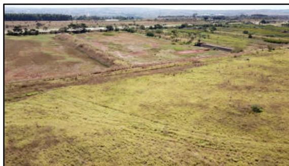
Foto 58: Bacias de retenção no trecho norte e nordeste da ADA.
