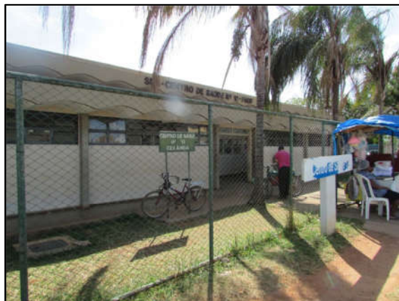
Foto 36: Centro de Saúde nº 12 da Ceilândia.
