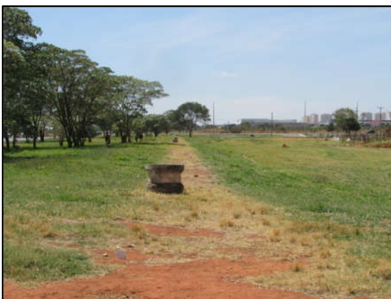
Foto 23: Poço de visita do sistema de drenagem de águas pluviais na RA de Ceilândia.
