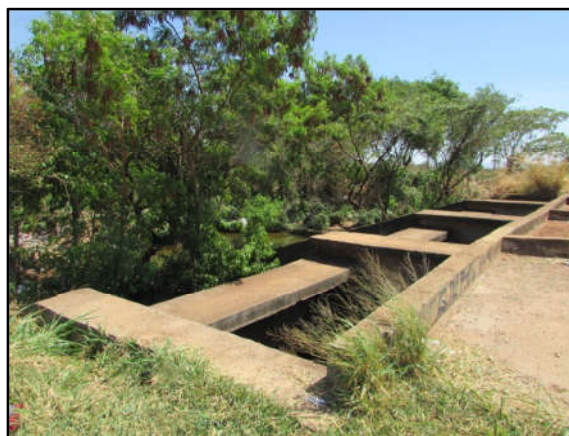
Foto 24: Dissipador de energia do sistema de drenagem pluvial na RA de Ceilândia.
