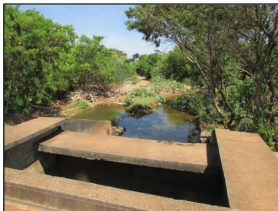
Foto 26: Dissipador de energia em ponto de lançamento do sistema de drenagem pluvial na RA Ceilândia.
