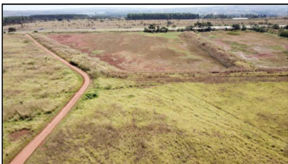
Foto 57: Bacias de retenção no trecho norte da ADA.
