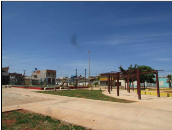
Foto 41: Ponto de Encontro Comunitário.
