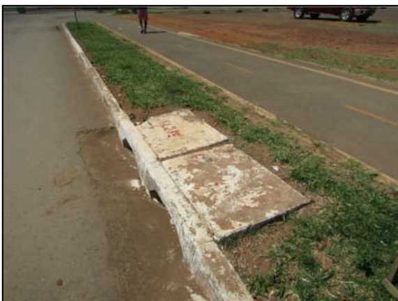
Foto 25: Bueiro na RA de Ceilândia.
