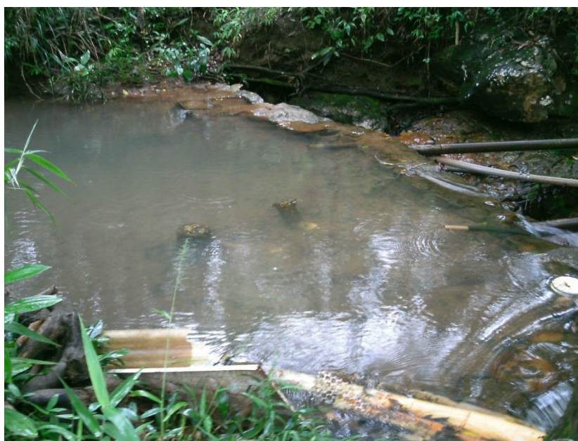
Foto 5 – Barramento para captação das águas do córrego Cachoeirinha, a montante da cachoeira. (Foto: Pedro Braga)
