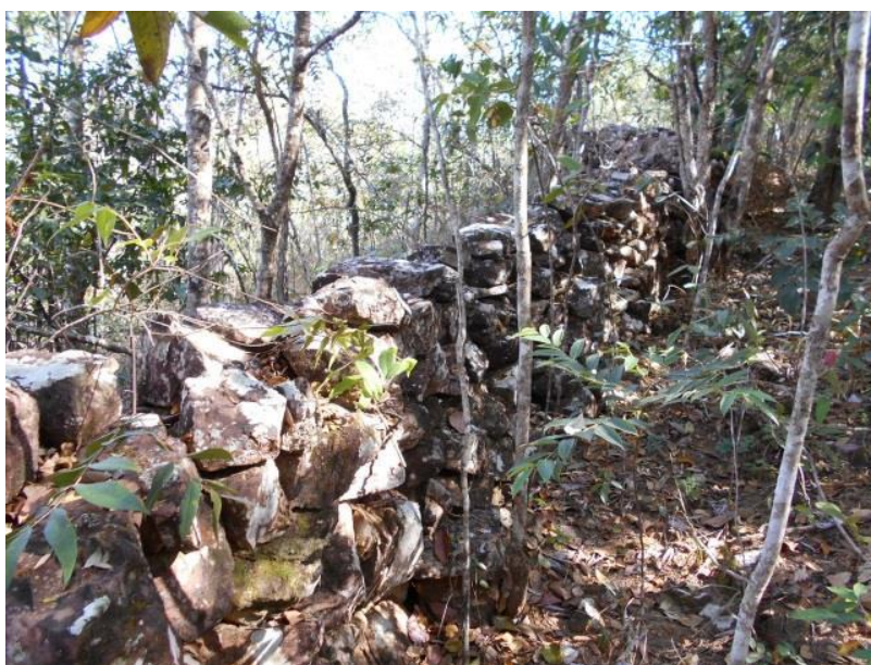
Figura 62 – Vista do Muro do Boqueirão erguido a partir de blocos de quartzito. Foto: Paranoá Consultoria & Planejamento Ambiental.
