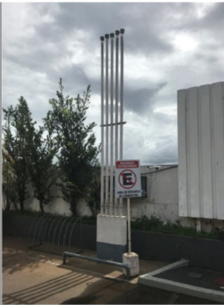
Foto 09. Respirios com terminais corta-chamas.
