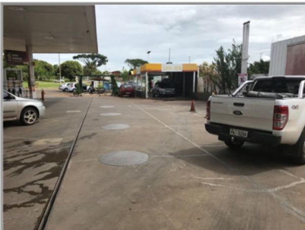
Foto 05. Área de tancagem.
