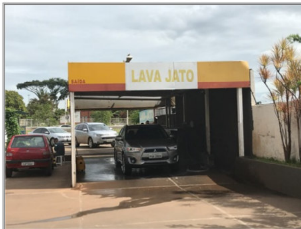
Foto 11. Vista geral da área de lavagem de veículos.
