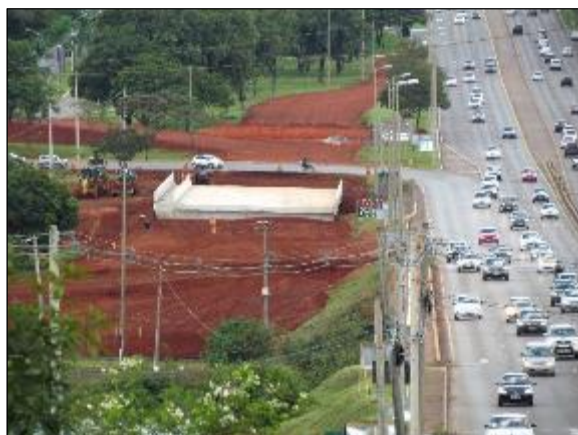
Foto 2.196: Obras do Trevo de Triagem Norte.
