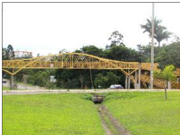
Foto 2.97: Drenagem pluvial DF-005 - altura da entrada do Varjão.
