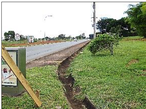
Foto 2.96: Vista drenagem pluvial acesso ao Lago Norte
