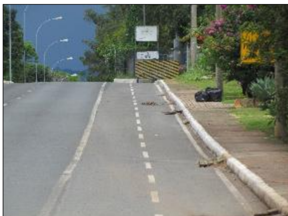
Foto 2.183: Ciclovia na DF-009.
