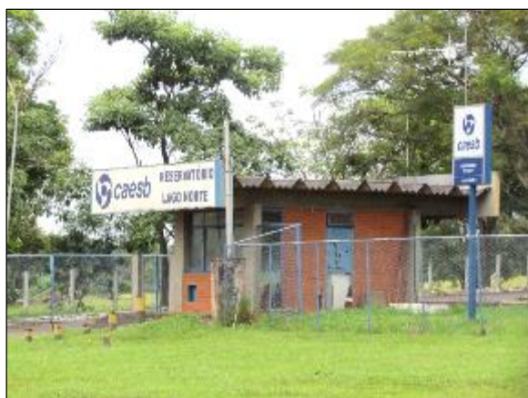
Foto 2.102: Reservatório da CAESB no Lago Norte.
