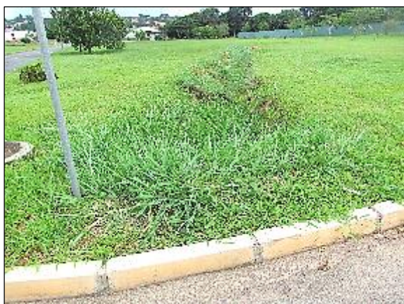
Foto 2.98: Drenagem na MI 3, Setor de Mansões - Lago Norte.
