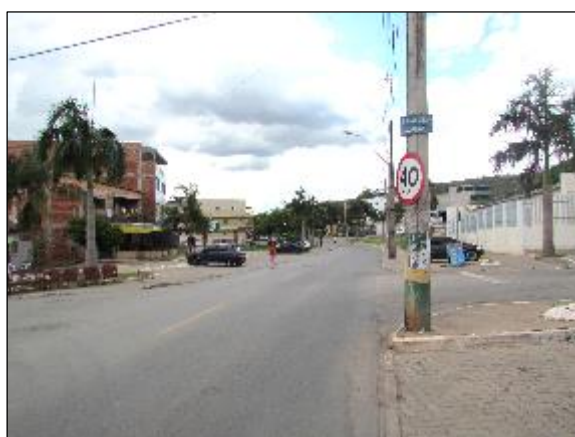
Foto 2.186: Vista da via principal do Varjão.
