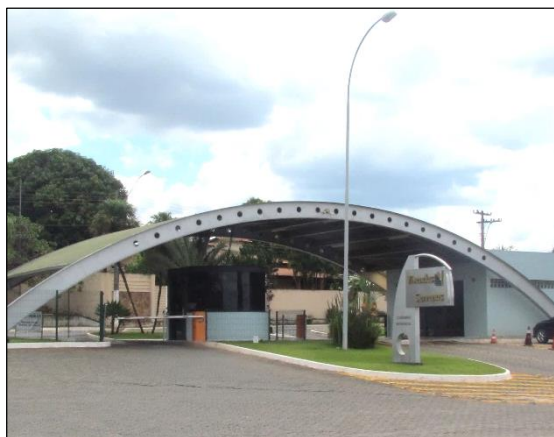
Foto 2.326: Vista do Condomínio Vivendas Serranas.
