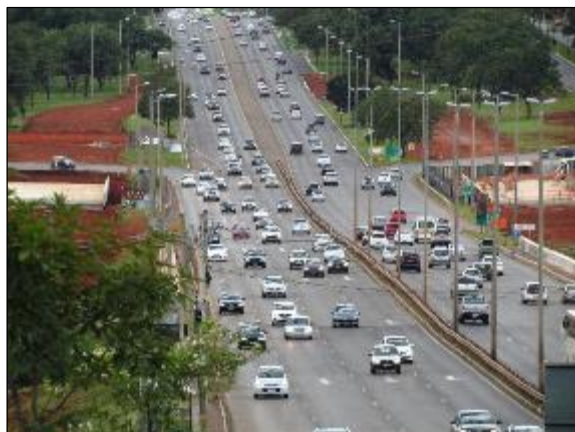
Foto 2.182: Visão da Ponte do Bragueto na DF-002 .
