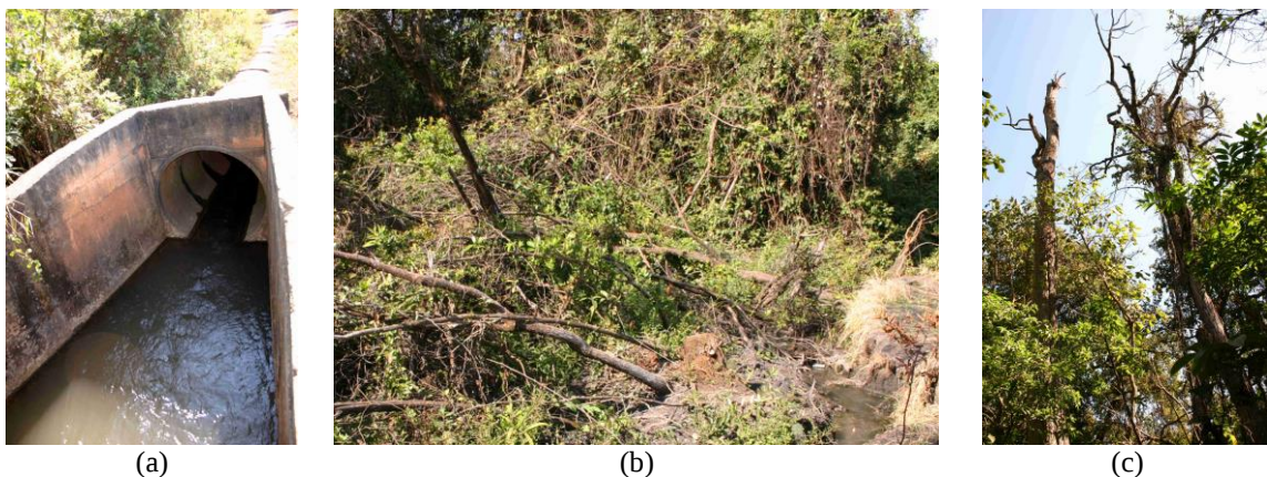
Figura 7 – Processo de degradação ambiental da mata de galeria do córrego Veredinha, desencadeado por lançamento de drenagem pluvial; (a) dispositivo de lançamento final, (b) efeito da enxurrada na calha do córrego e (c) mortalidade de indivíduos arbóreos dominantes e emergentes.
