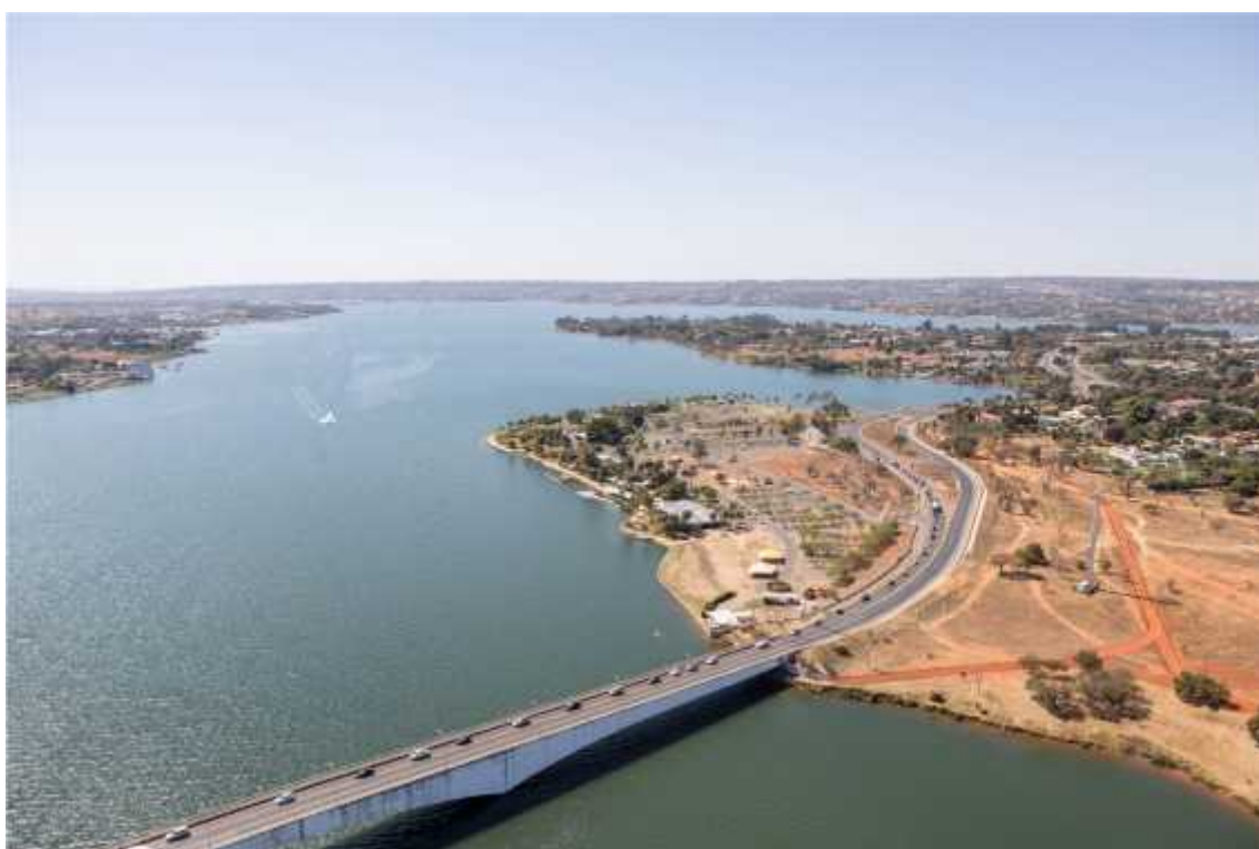
Figura 3-11 - Vista aérea da ponte Honestino Guimarães (2016). Fonte: Projeto Orla. Secretaria de Estado de Gestão do Território e Habitação (2016).
