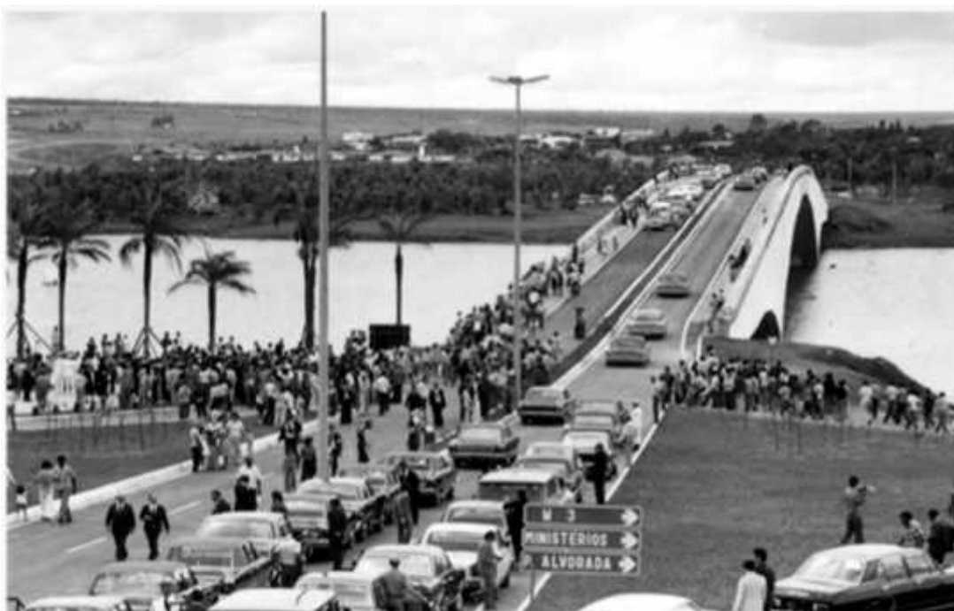
ARQUIVO PÚBLICO DO DF SCS.IF.7.3.C.1 Nº 89187 CONTEÚDO: VISTAS DA CIDADE - INAUGURAÇÃO DA PONTE COSTA E SILVA LOCAL: BRASÍLIA-DF DATA: 06/02/1976 AUTOR: NÃO IDENTIFICADO
