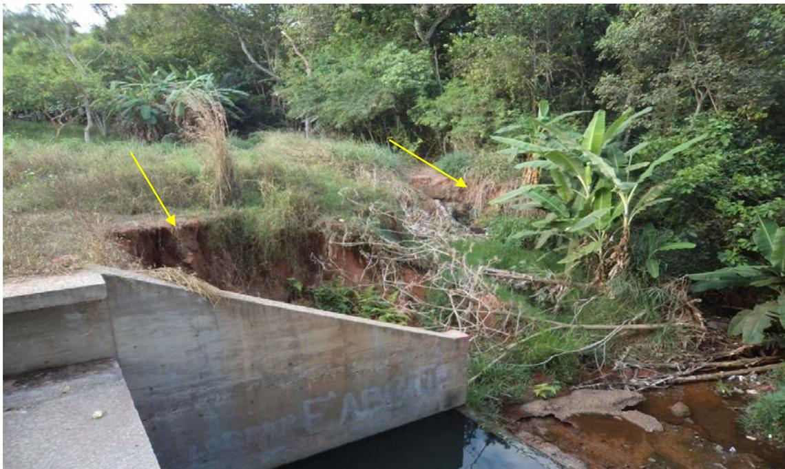
*Figura 39 - Lançamento de drenagem pluvial na área sul da UC. Notar os processos erosivos em estágio avançado, destacados na seta amarela (MF100 - 181.718E/ 8.248.810N).*
