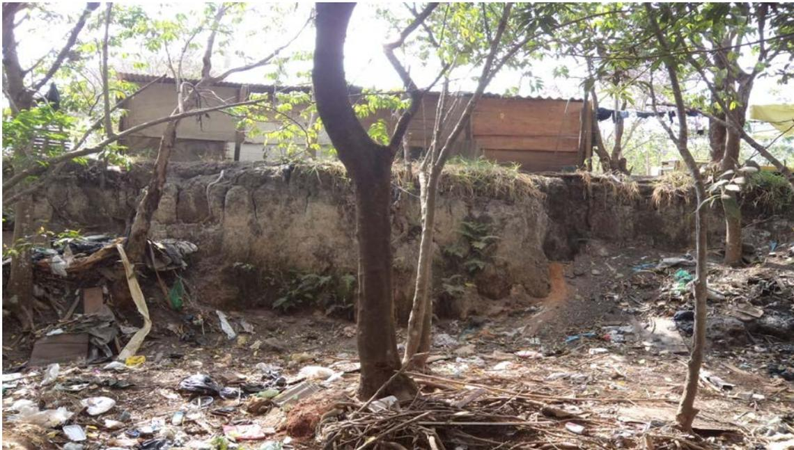
*Figura 38 - Processos erosivos em estágio avançado. Notar ocupação irregular com risco de desabamento (MF33 - 180.387E/ 8.250.885N).*
