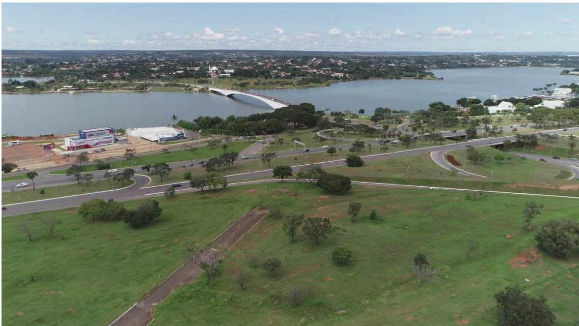
Foto 184. Vista da área Sudoeste da Gleba C do Parque Bosque dos Tribunais, destacando a via sem saída que delimita o parque.
