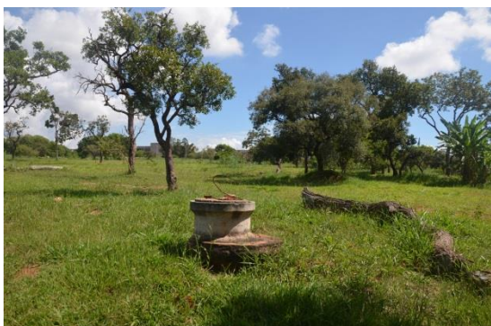
160. Poço de visita da rede de esgoto que passa pela Gleba A.
