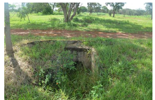
156. Vista da manilha de passagem das águas pluviais sob a via interna da Gleba A.
