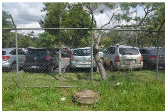
161. Poço de visita da rede de águas pluviais que passa pela Gleba A, ao lado do estacionamento.
