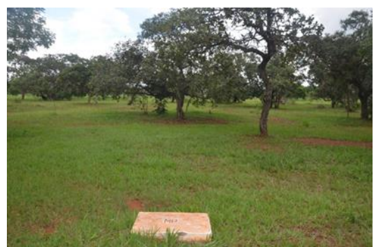
165. Caixa de passagem de rede do MP que passa pela Gleba A.
