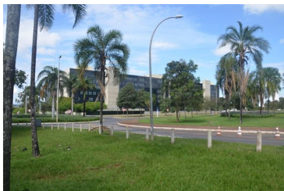
145. Vista do sistema viário de acesso ao estacionamento do STJ, ao lado da Gleba A.
