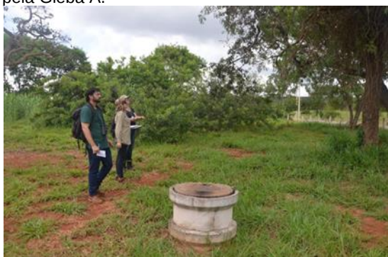
163. Poço de visita da rede de esgoto que passa pela Gleba A.
