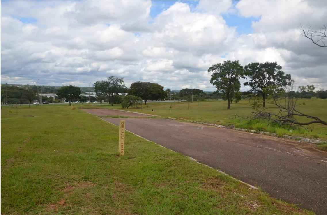
Foto 5: Área mais suscetível à erosão, com pista sem saída e sem rede de drenagem, no sudoeste da Gleba C do Parque Bosque dos Tribunais (SAF / SES).
