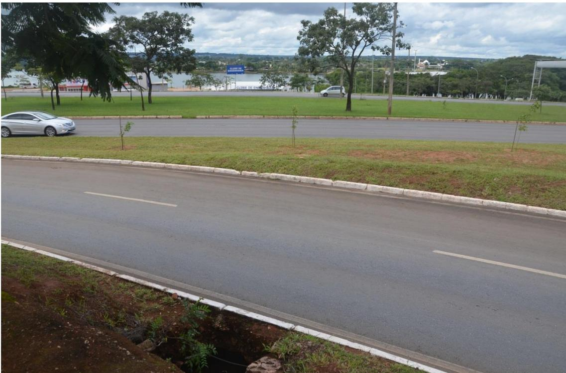
Foto 6: Área erodida, ao sudoeste da Gleba C do Parque Bosque dos Tribunais, colocando em risco a base da pista de ligação da Estrada Parque das Nações (Via L4) com a Via da Ponte Honestino Guimarães.
