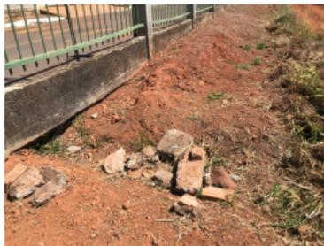
Foto 18 – Abertura para a saída da vazão pluvial, sem dispositivos de drenagem, para o lote vizinho ao parcelamento
