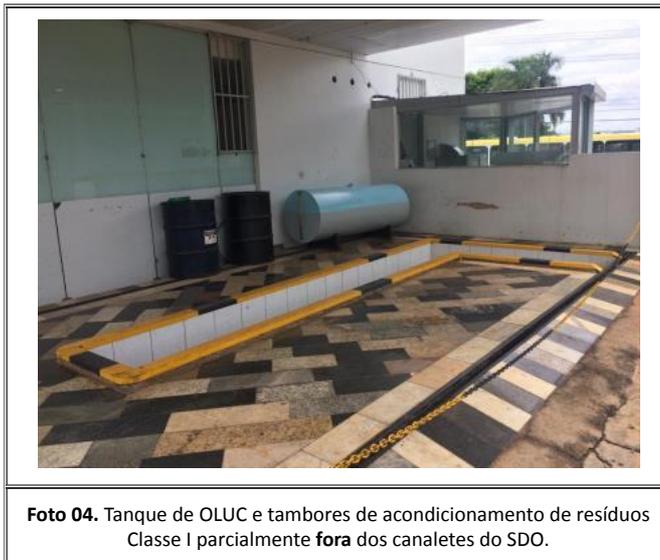
Foto 04. Tanque de OLUC e tambores de acondicionamento de resíduos Classe I parcialmente **fora** dos canaletes do SDO.
