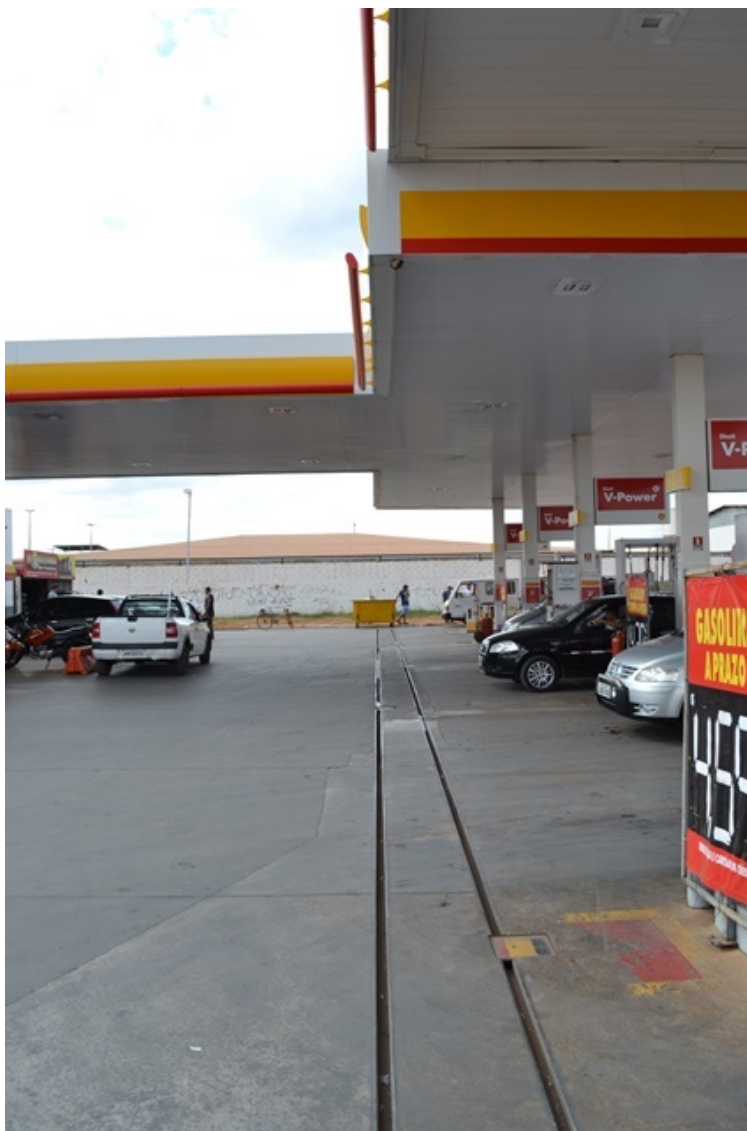
Figura 10: Canaletes da Pista de Abastecimento ligados ao S.AO.
