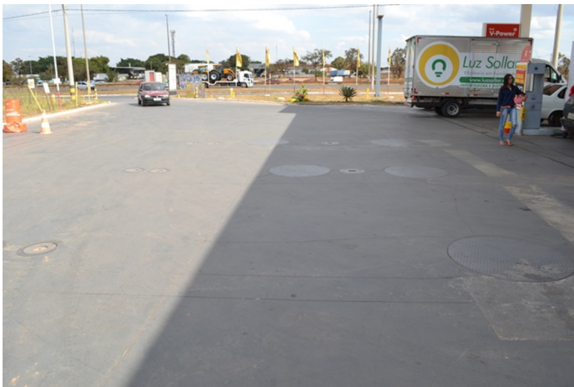
Figura 2: Área de tancagem contendo três tanques (dois bipartidos e um pleno).
